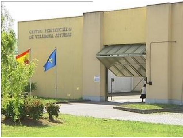
Imagen 1.-Entrada Prisión de Villabona después de la remodelación. 2010. Fuente: On line
