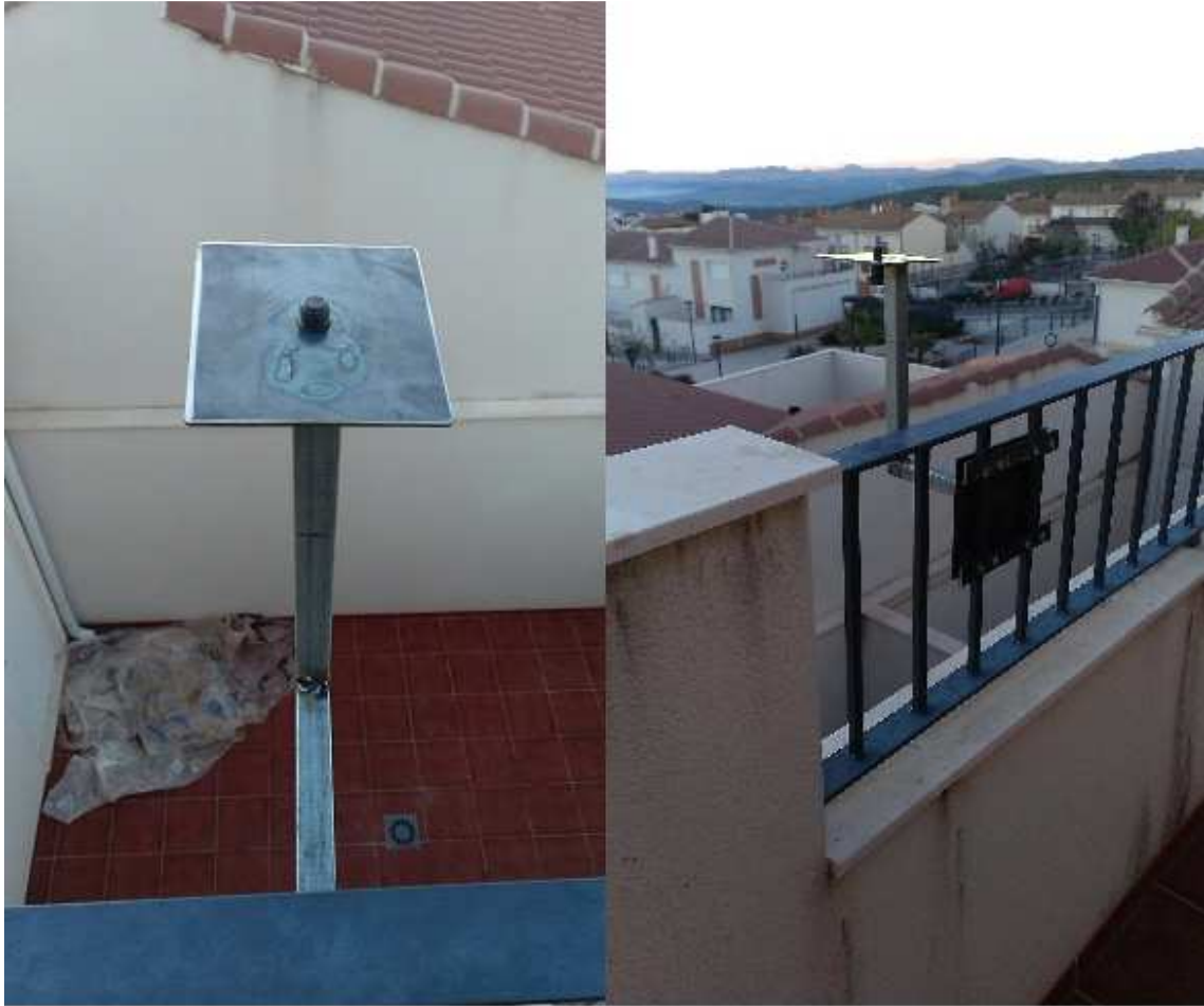
Figura 33. Ilustración de la base superior y del anclaje a la baranda.
