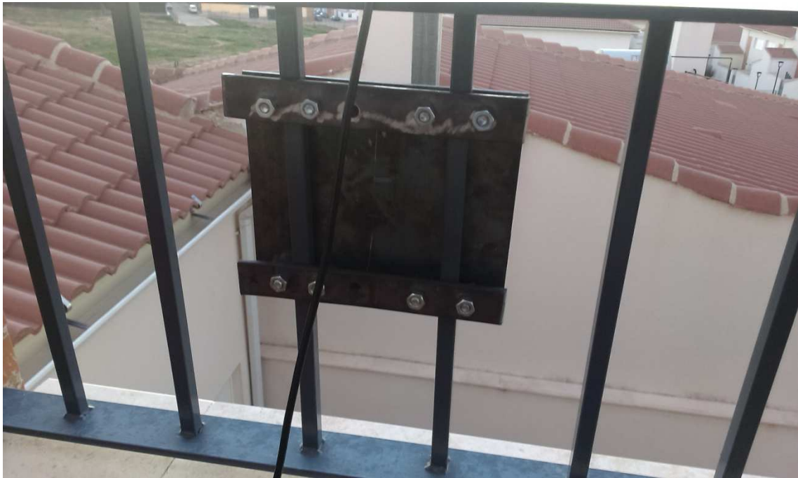
Figura 34. Ilustración de detalle del anclaje a la baranda del soporte para el receptor.
