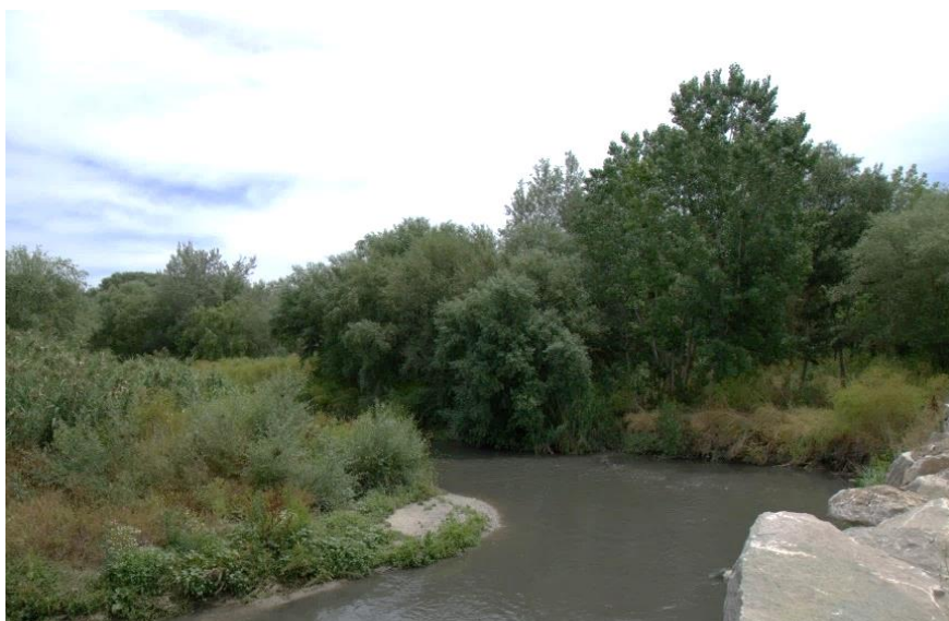
Imagen 43: Estado del tercer tramo donde se aprecia un muro de rocas y hormigón en el margen izquierdo.
