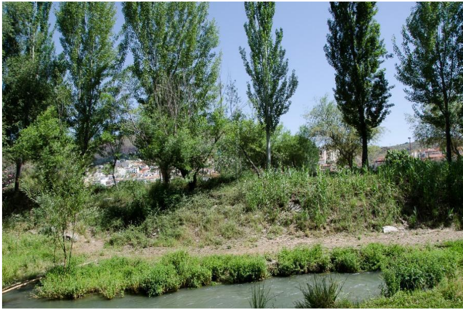
Imagen 91. Talud del margen derecho.
