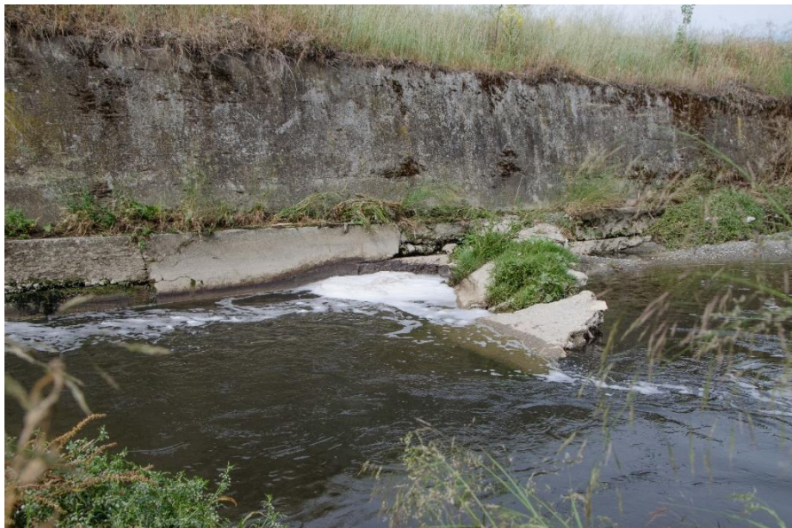
Imagen 68. Muro del canal en el primer punto.
