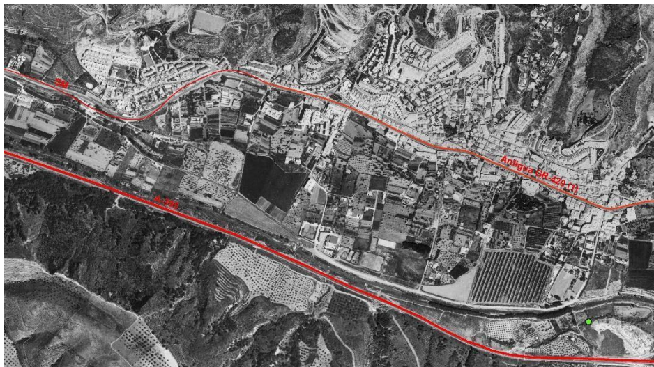
Imagen 46. Ortofoto del año 1997, en la que se aprecia la canalización del río Genil
