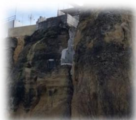
Figura 28. Ventana en la roca.
