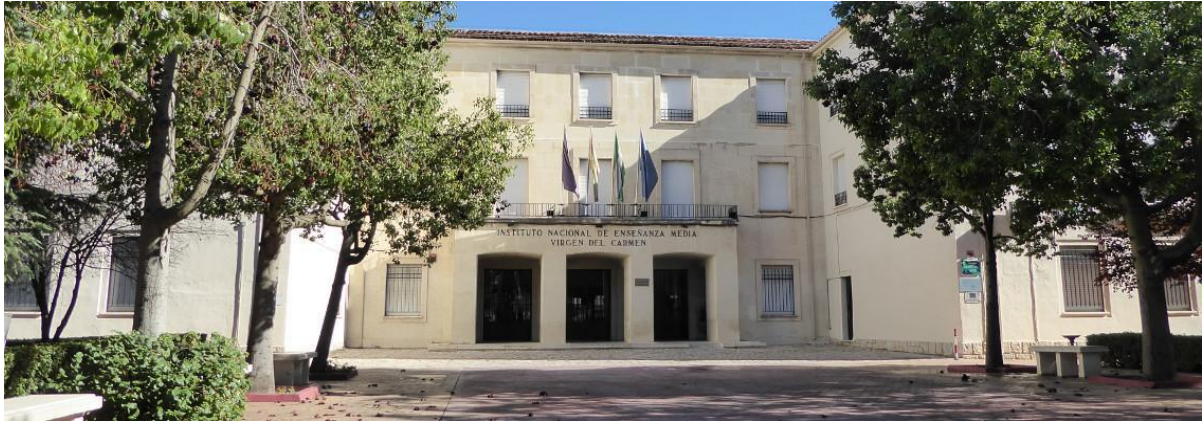
Ilustración 2. Fachada del edificio principal.
