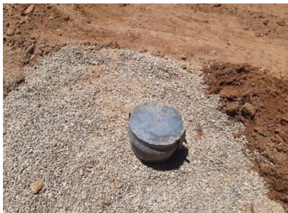
Figura 31. Tapa de acero provisional.
