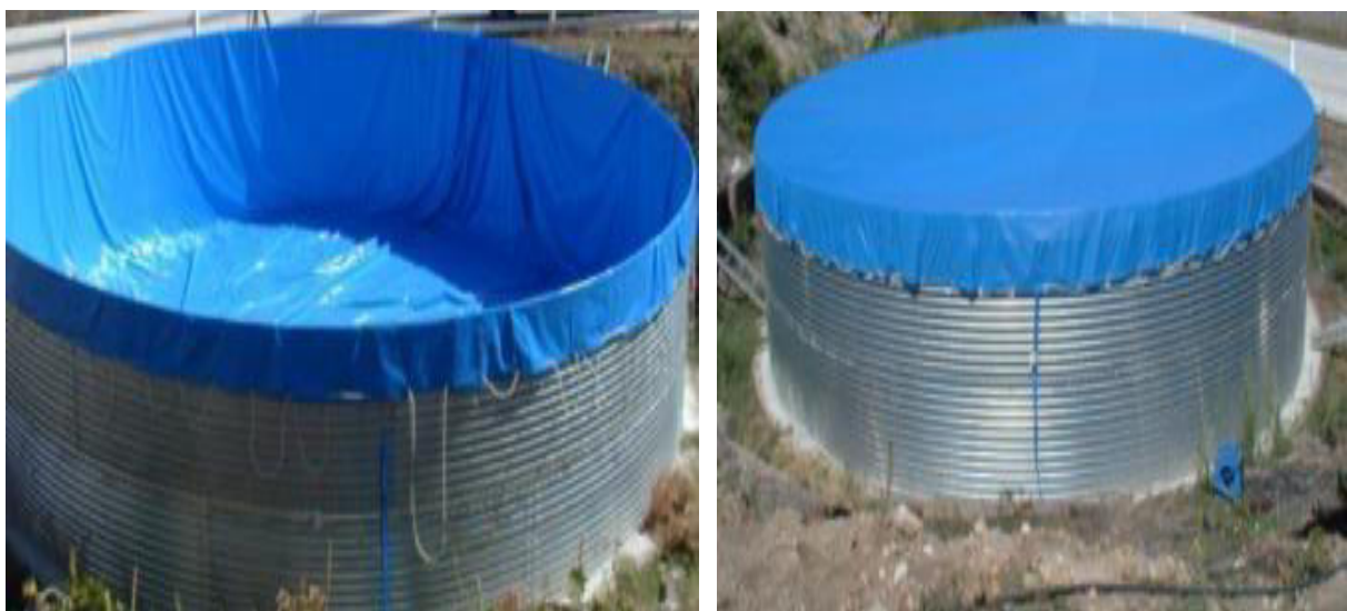
Figura 30. Impermeabilización de la balsa Fuente: https://ilurco/depositos-de-agua/
