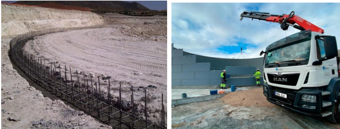
Figura 28. Cimentación y montaje balsa Ilurco Fuente: https://ilurco/depositos-de-agua/
