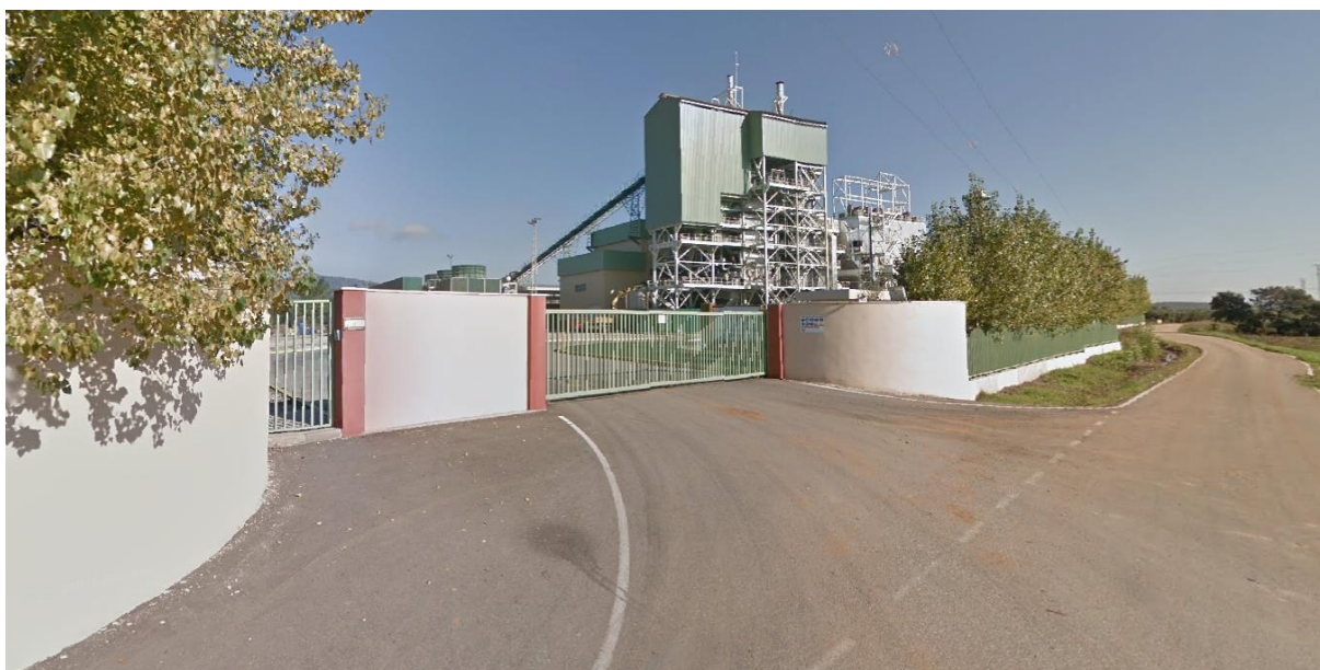
Figura 1. Vista de la planta Aldebarán Energía.
