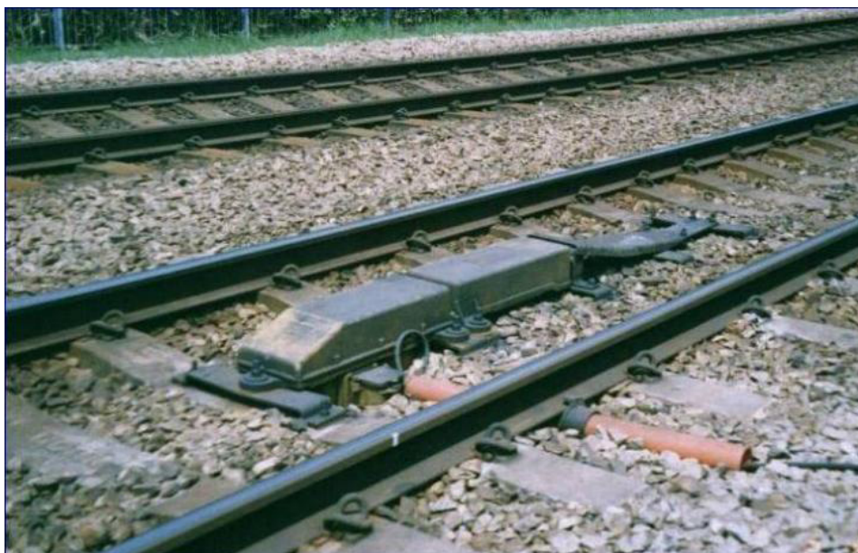
Figura 53: La rampa de AWS
