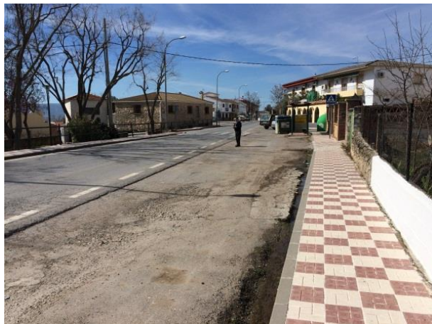
FIGURA 18.29- Sección ampliada para parada de autobuses
