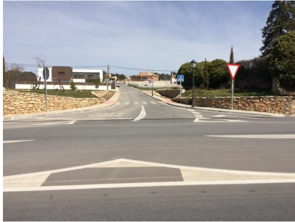
FIGURA 18.11- Intersección con calle camino de frailes P.K. 0+472, se puede ver el sobre ancho de la actuación de 2015
