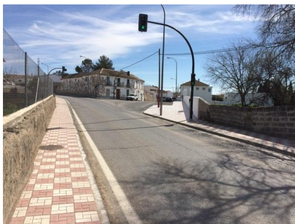
FIGURA 18.21- Intersección con calle escuelas P.K. 1+337
