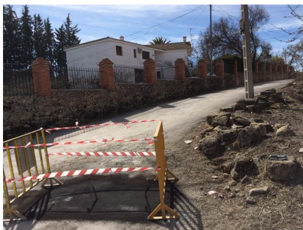
FIGURA 18.35- Intersección con calle fábrica P.K. 2+074
