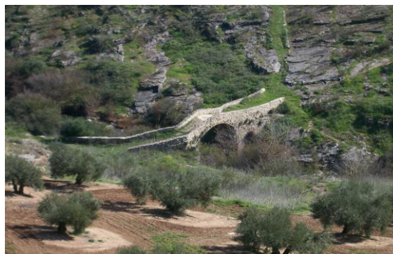
54.- Puente medieval sobre el río Víboras.
