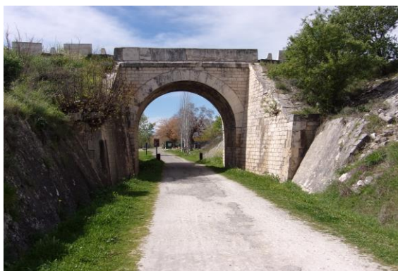
92.- Taludes y paso superior en Doña Mencía. (Lado este)
