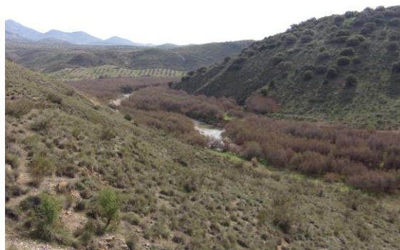
75.- Cauce del río Guadajoz desde el viaducto.
