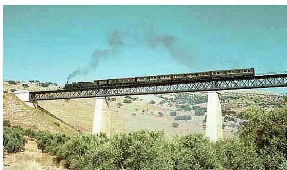
100.- Tren Correo Pte. Genil-Linares. Viaducto de la Sima (1966).
