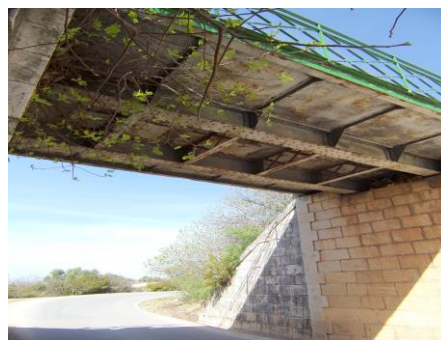
97.- Pontón en Km. 80.8 de la Vía Verde del Aceite
