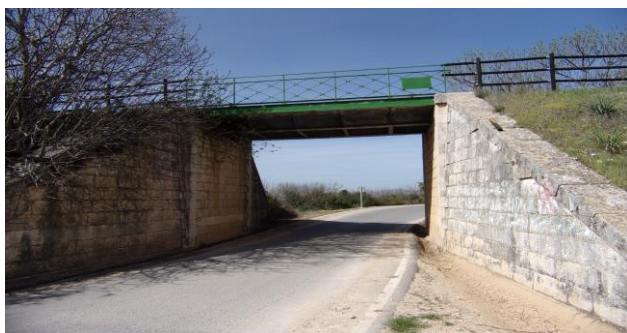
96.- Pontón en el Km. 80.8 de la Vía Verde del Aceite.
