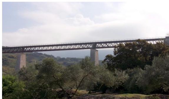
101.- Viaducto de la Sima. (2020).
