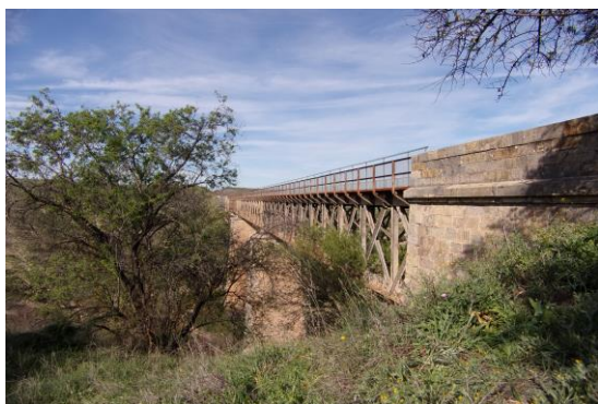
43.- Vista lateral del viaducto del Higueral.
