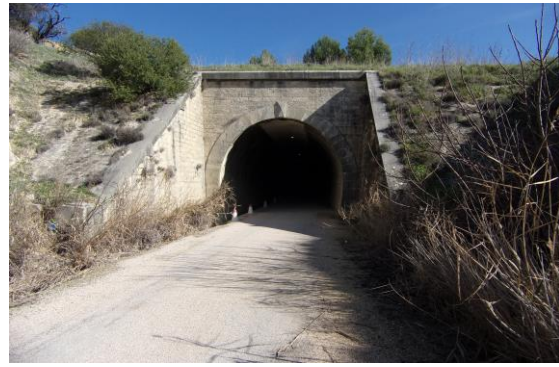
26.- Boca de salida túnel del Caballico lado este.
