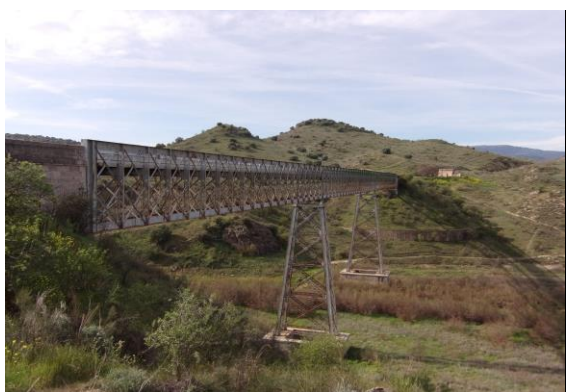
74.- Viaducto sobre el río Guadajoz.
