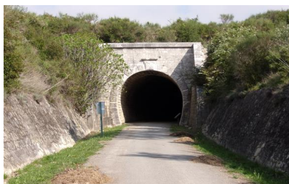
99.- Túnel del Plantío. (Boca sur).
