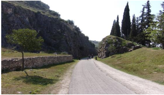
114.- Trinchera en el Km. 88.2, junto a la Fuente del Río.
