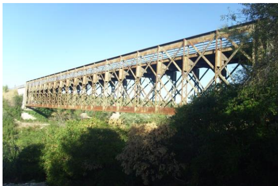
118.- Vista lateral del viaducto del Alamedal.
