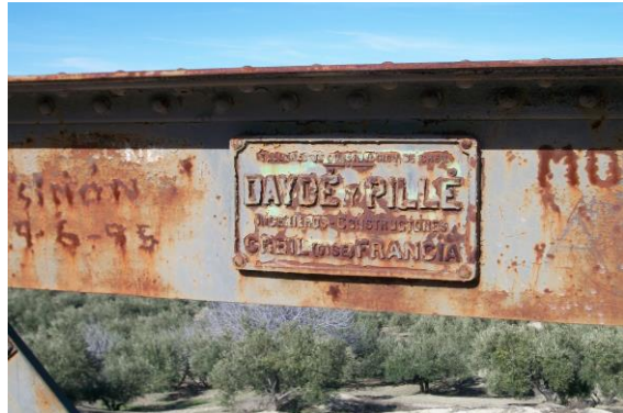
32.- Placa identificativa de los constructores del viaducto.
