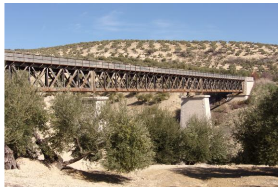
28.- Vista del viaducto sobre sus pilares.
