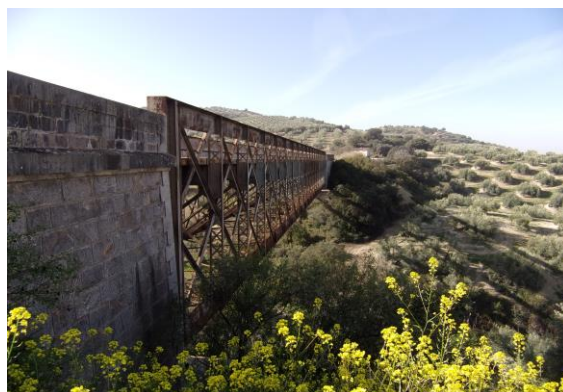
56.- Vista lateral del viaducto del Chaparral.
