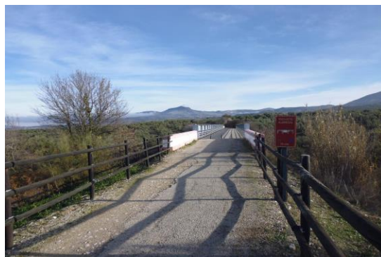
119.- Viaducto del Alamedal.
