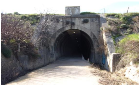
23.- Boca entrada túnel del Caballico lado oeste.
