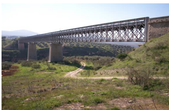
53.- Vista lateral del viaducto sobre el río Víboras.
