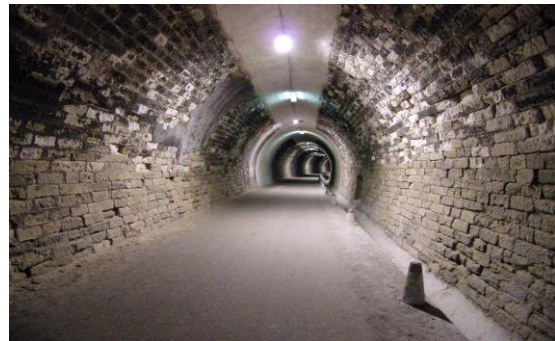
24.- Interior en curva del túnel del Caballico.
