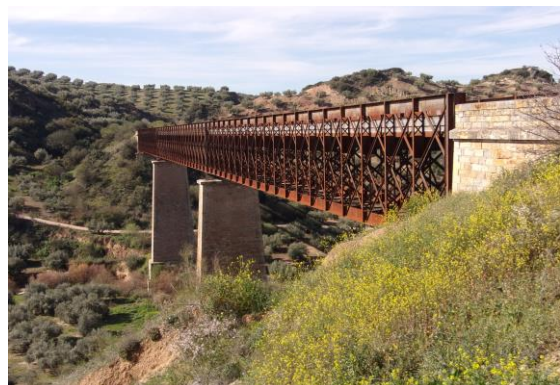
42.- Vista lateral del viaducto.
