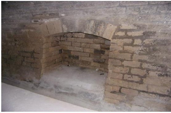
25.- Detalle de una tronera en el interior del túnel.
