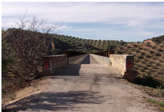
41.- Viaducto sobre el arroyo Salado.
