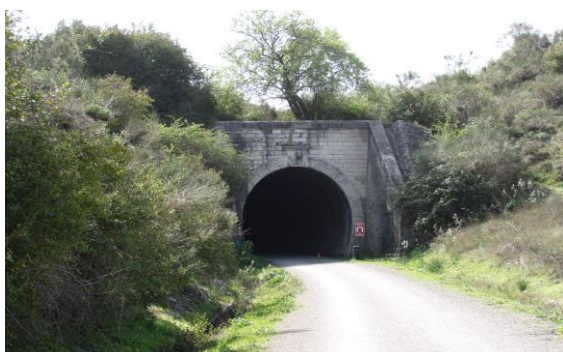
98.- Túnel del Plantío. (Boca norte).
