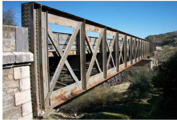
30.- Vista lateral del viaducto apoyado sobre una pilastra.
