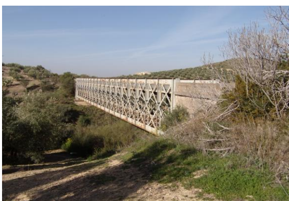
58.- Vista lateral del viaducto de La Esponela.
