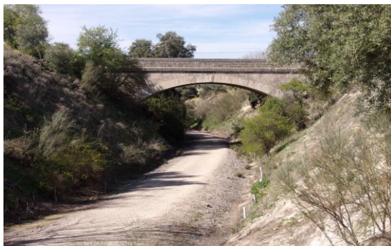
51.- Paso superior de la carretera JA-2235 sobre la Vía Verde.
