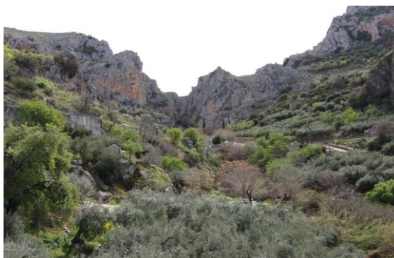
89.- Cañón del Río Bailón desde el viaducto de Zuheros.
