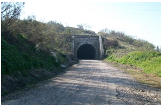
33.- Boca norte del túnel de Torredonjimeno.
