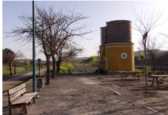
62.- Depósitos de agua “cubatos” de la estación de Alcaudete.
