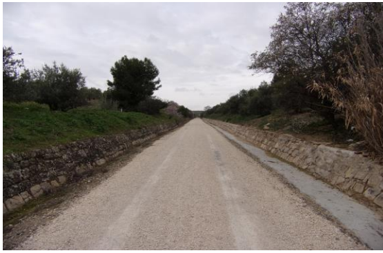
19.- Taludes en torno al Km. 2,7 de la Vía Verde del Aceite.
