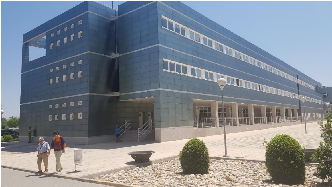
Figura 111. Imagen exterior del edificio.
