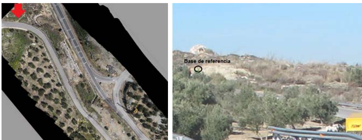
Figura 3.7. Implantación de una base de referencia en una zona estable y externa a la carretera.
