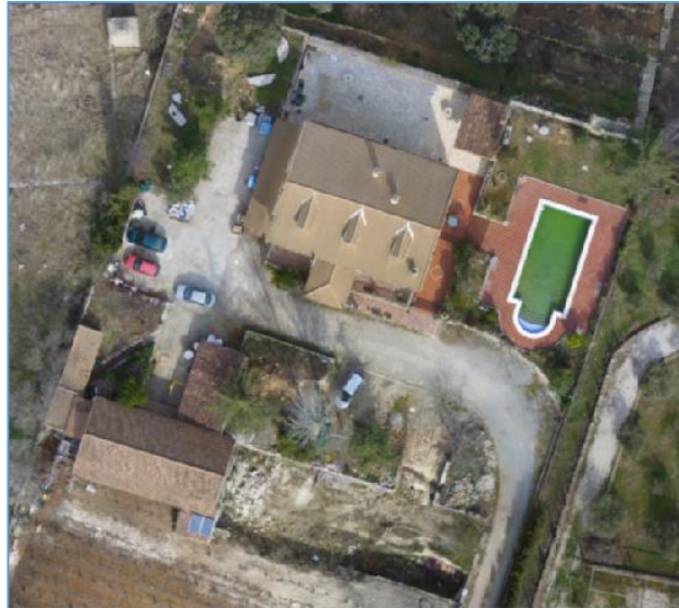
Fig.60 Construcciones en El Cascante
