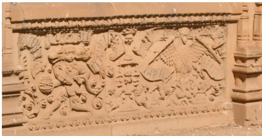
Fig.35) Antepecho de la galería exterior del Claustro de la Universidad de Salamanca (siglo XVI).
