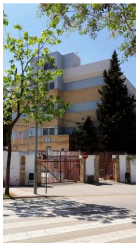
Fig. 12. Vista de la fachada principal del Instituto Politécnico de Enseñanza Secundaria “Reyes de España” de Linares, Jaén. Título: La puerta de un sueño vocacional. Fotografía propia.
