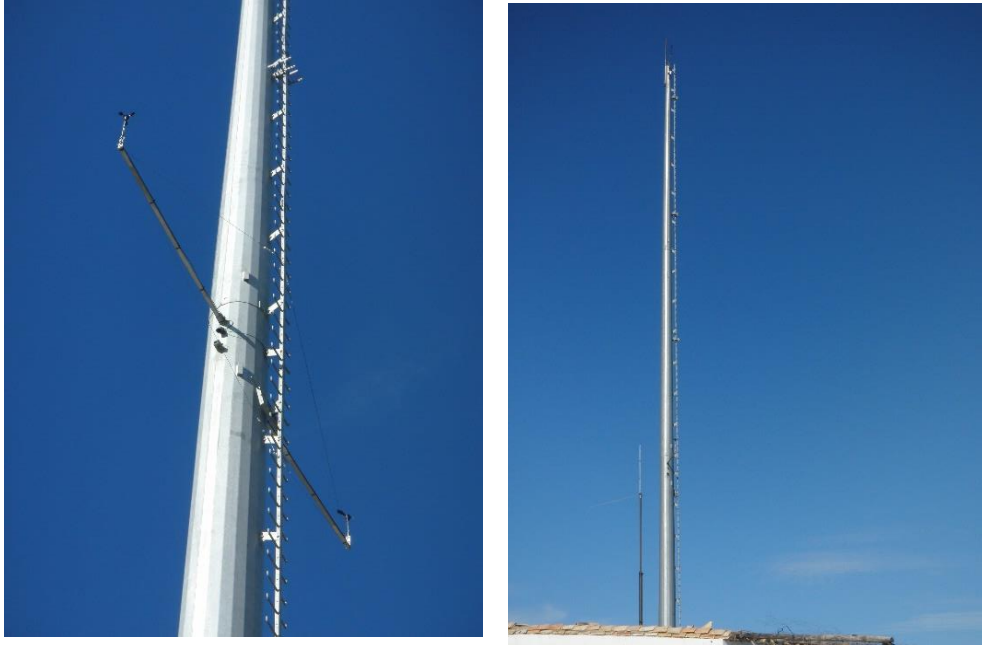
Figura 6. Imágenes de la torre de medición del viento en el parque de Sierra del Trigo.
