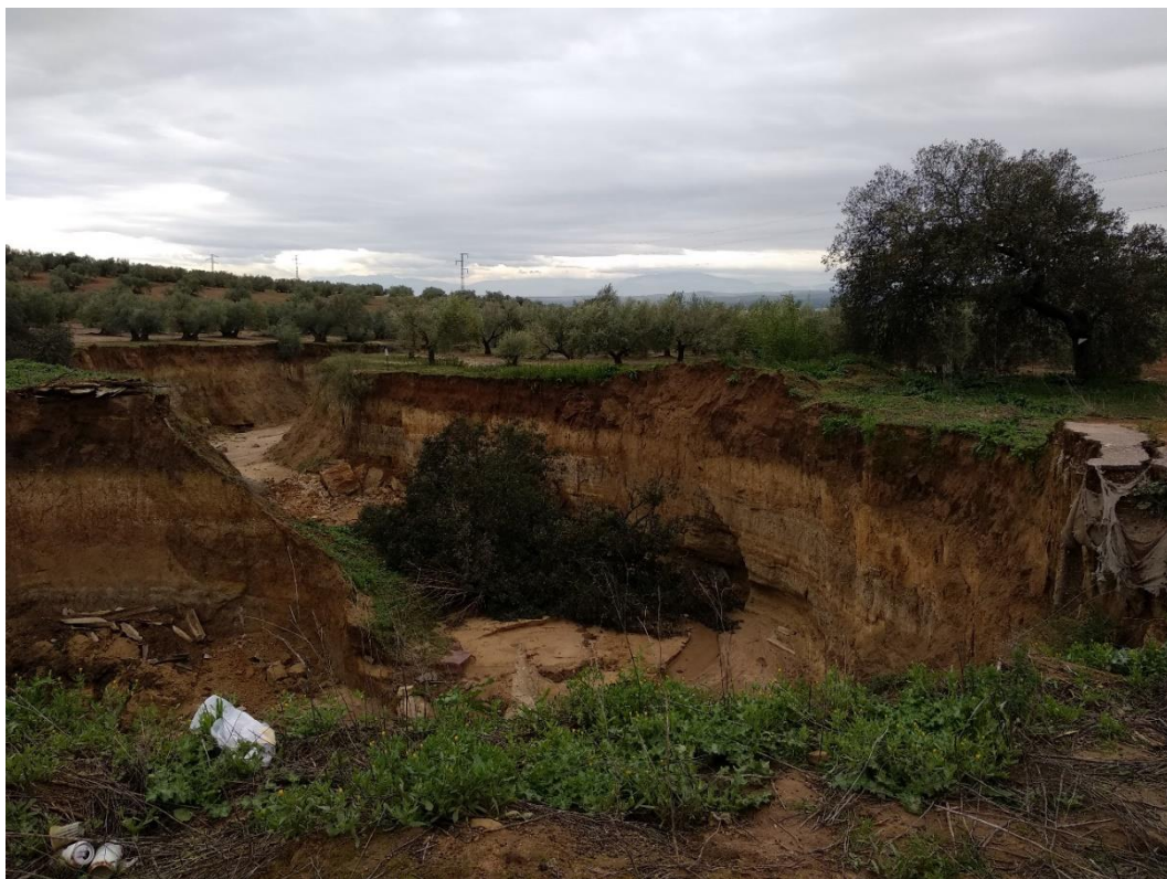
Figura 2: Enormes cárcavas con desprendimiento de suelo fértil en un olivar cercano a Jaén capital. Fuente: Fotografía propia. 2018
