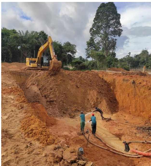
Figura 40: Proceso de arranque secundario mediante monitores hidráulicos.
