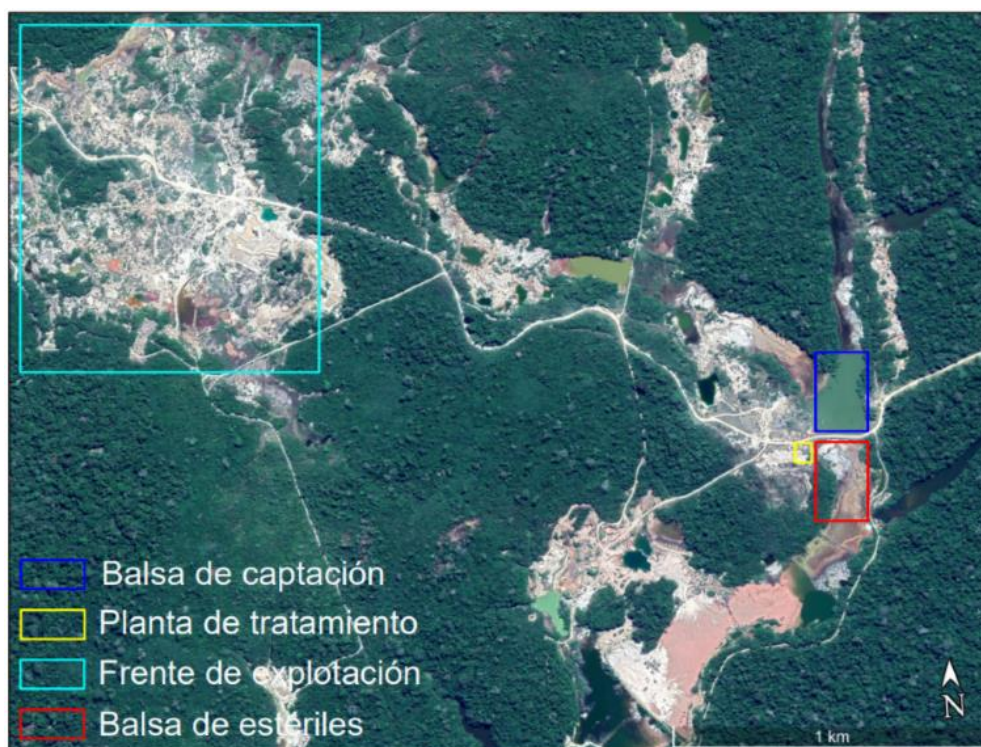
Figura 65: Ubicación de la planta de tratamiento.
