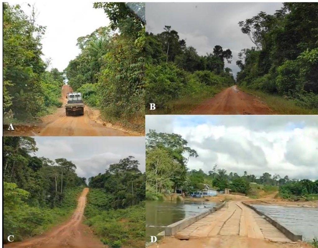
Figura 4: (A), (B) y (C) Carreteras de acceso a la explotación. (D) Puente sobre el río Madeirinha.
