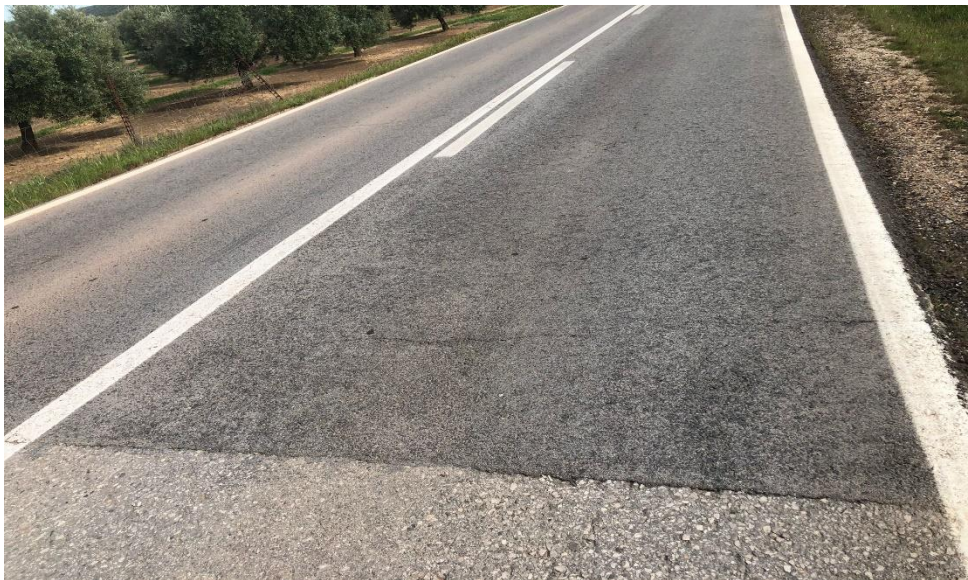
Figura 1. Transición entre capas de pavimentos de distintas edades.
