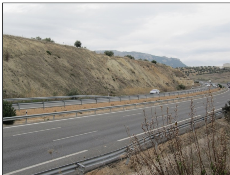
Imagen 2. 4. Panorámica del talud al completo
