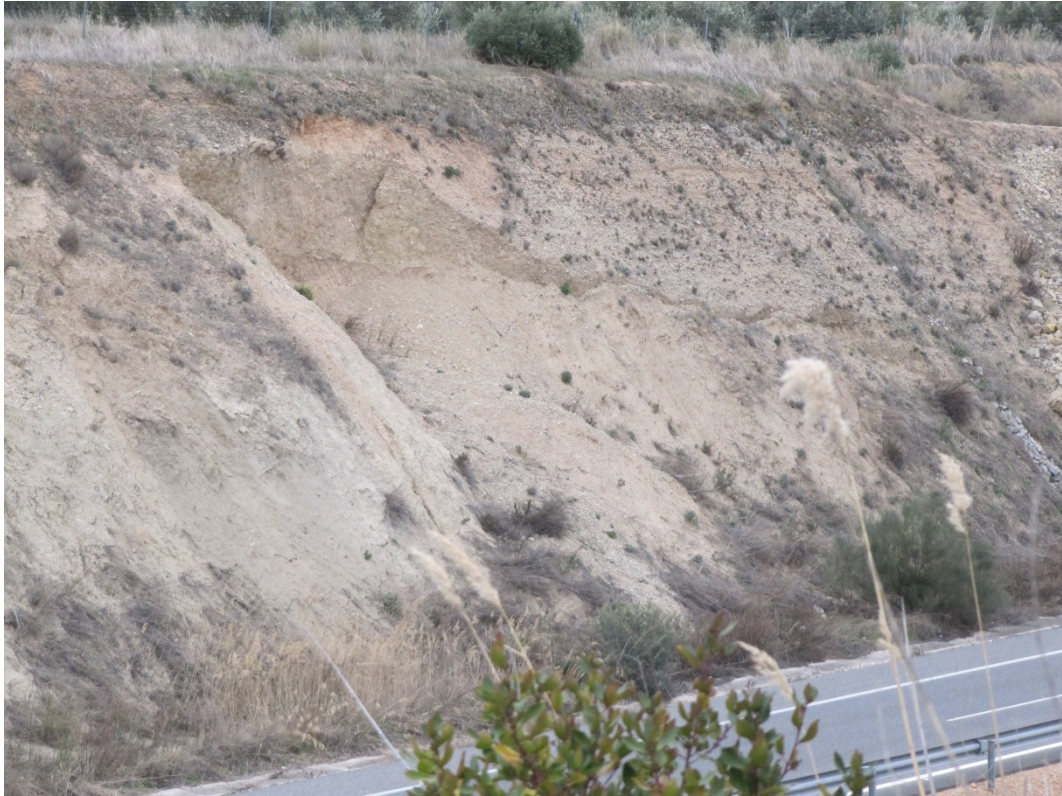
Imagen 2. 5. Detalle del talud
