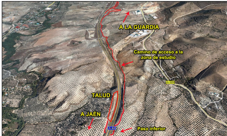
Imagen 2. 3. Ruta de acceso al talud
