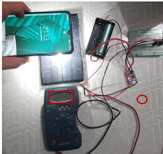
Figura 5.21. Prueba de funcionamiento del sistema fotovoltaico cargando la batería con un móvil
