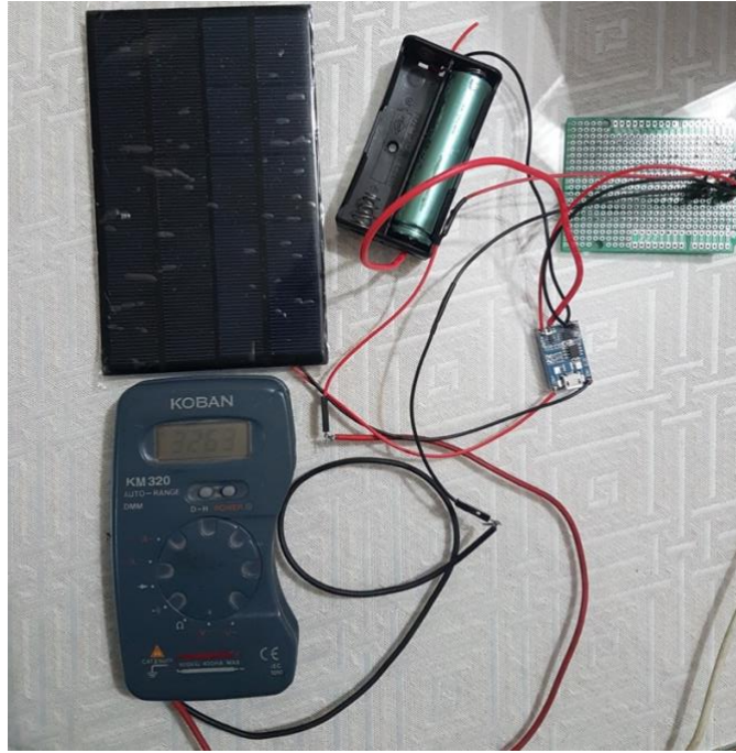
Figura 5.20. Montaje final del sistema eléctrico fotovoltaico
