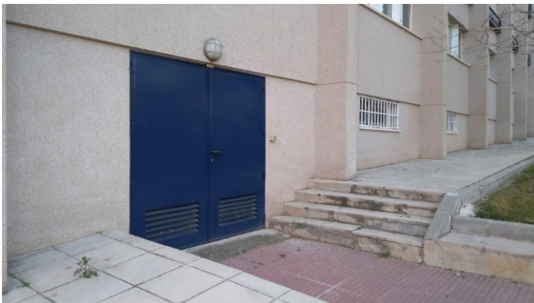
Figura 1.8. Entrada del sótano del edificio B-3 (900 E).
