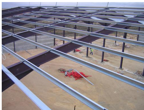
Figura 4.5. Correas en cubierta
