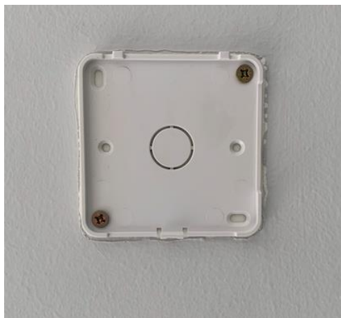
Figura 73. Instalación tapa trasera del sensor
