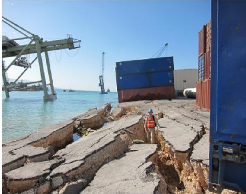
Figura 6.15. Colapso del Muelle Norte (DesRoches et al., 2011).
