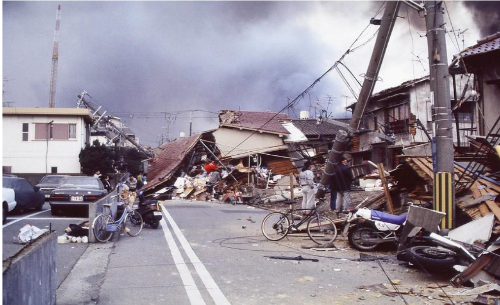
Figura 6.8. Destrucción en Kobe tras el terremoto. Nota. De Kobe Earthquake (1995) , por Japan Nakama, 2021. Japan Nakama | The Kobe Earthquake: January 17th 1995
