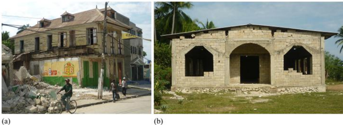
Figura 6.14. Estructuras más ligeras que resistieron al derrumbe (DesRoches et al., 2011).
