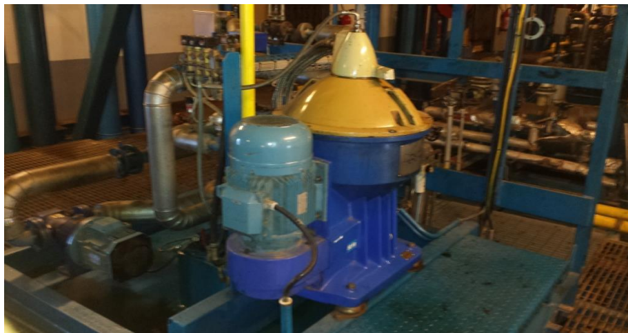
Figura 5. 12-Separador de aceite de lubricación.
