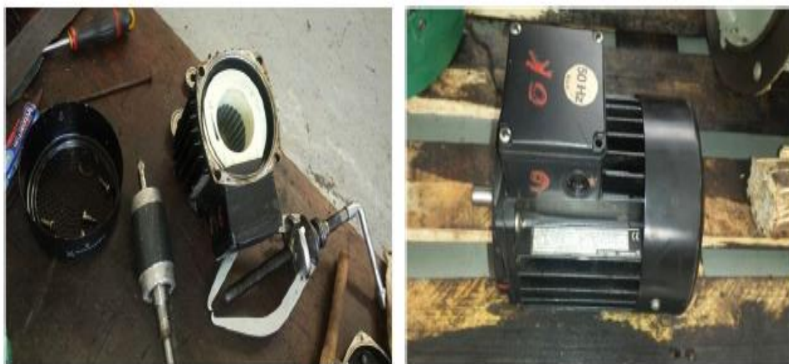
Figura 8. 26-Mantenimiento de motores de precalentado.
