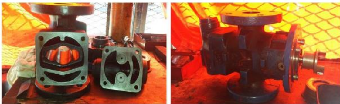
Figura 8. 19-Mantenimiento de las bombas de alimentación forzada.
