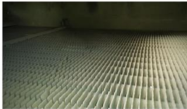
Figura 8. 21-Mantenimiento de la caldera.
