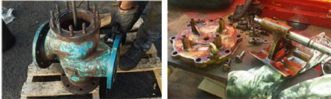
Figura 8. 20.Mantenimiento de válvulas de 3 vías de agua BT Y AT. []
