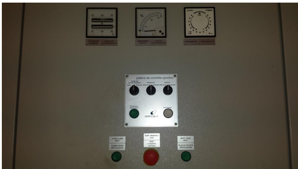
Figura 7. 8-Unidad de sincronización. propia
