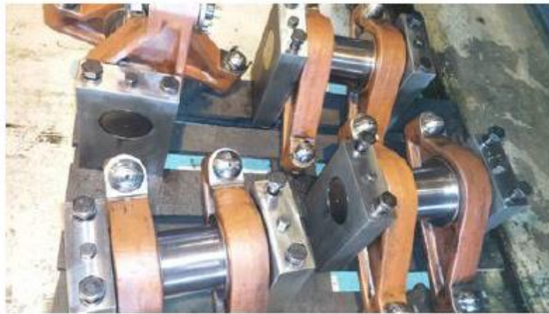
Figura 8. 10-desmontaje y limpieza de los Balancines.
