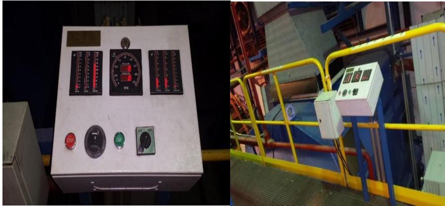
Figura 7. 5-Arranque desde la unidad de comando local.
