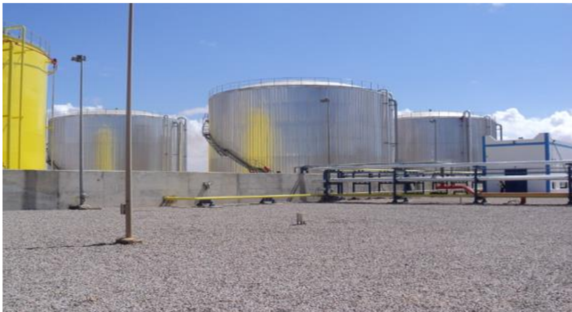
Figura 5. 3-Tanques de Fuel-oíl BIA de 5000m3.
