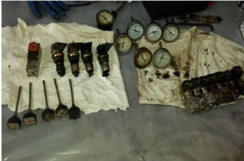
Figura 8. 27-Mantenimiento de los Sensores de presión y temperatura.
