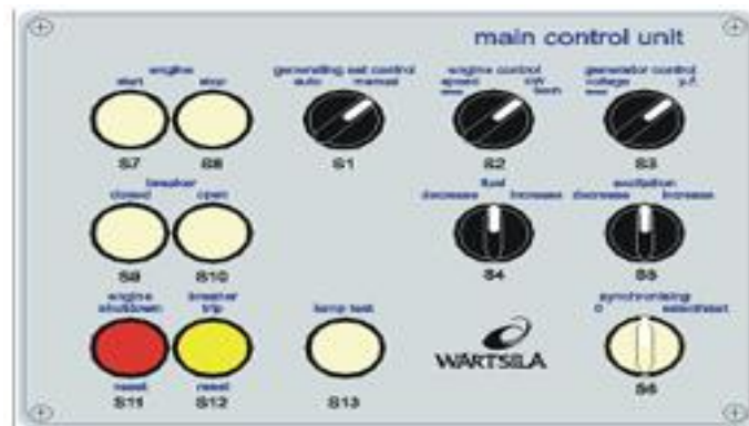
Figura 7. 7-Unidad de comando manual.
