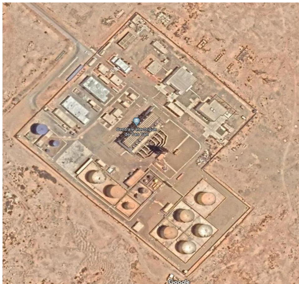
Figura 3. 1- Localización de la central Diésel de TAN TAN.
