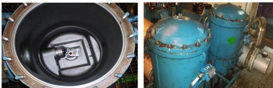
Figura 8. 2-Mantenimiento de los filtros de aceite y combustible. []
