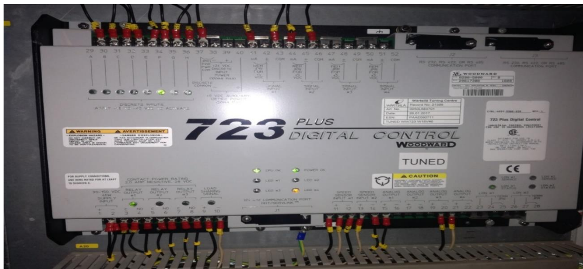
Figura 7. 11-Regulador de velocidad WOODWARD.
