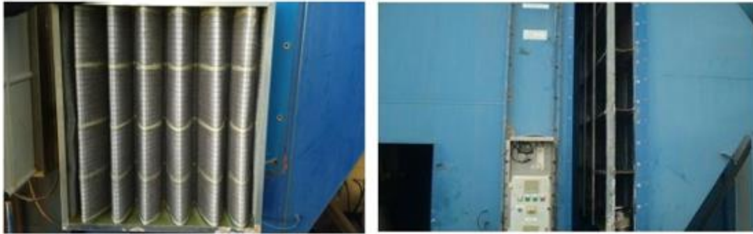
Figura 8. 17-Retirar, limpiar y volver a montar los filtros.
