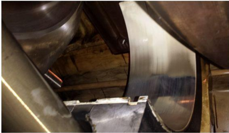
Figura 8. 12-Mantenimiento del cojinete
