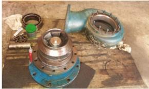
Figura 8. 16-Mantenimiento de bombas de Alta temperatura.
