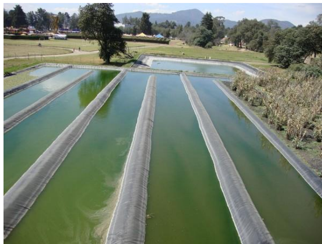
Figura 6. Humedal artificial. Fuente: https://ecotec.unam.mx/ecoteca/humedales-artificiales-2
