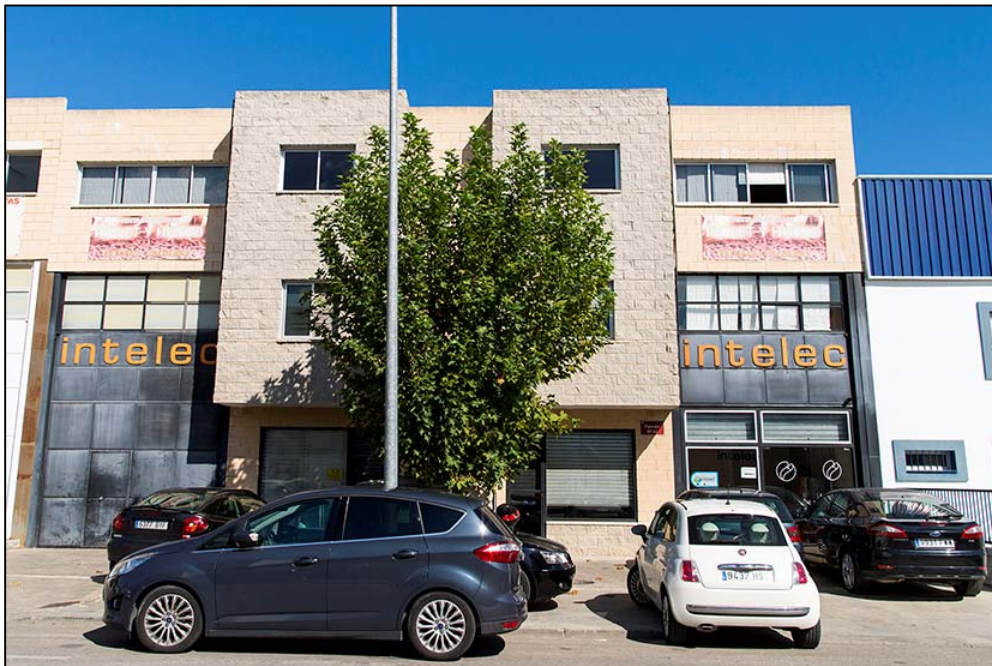
FIGURA 12. INSTALACIONES DE INTELEC EN JAÉN (FUENTE: INTELEC, 2016)
