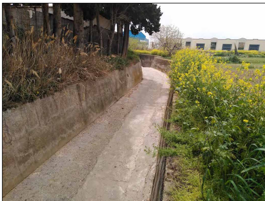
Figura 3.4. Encauzamiento del barranco del Purcal
