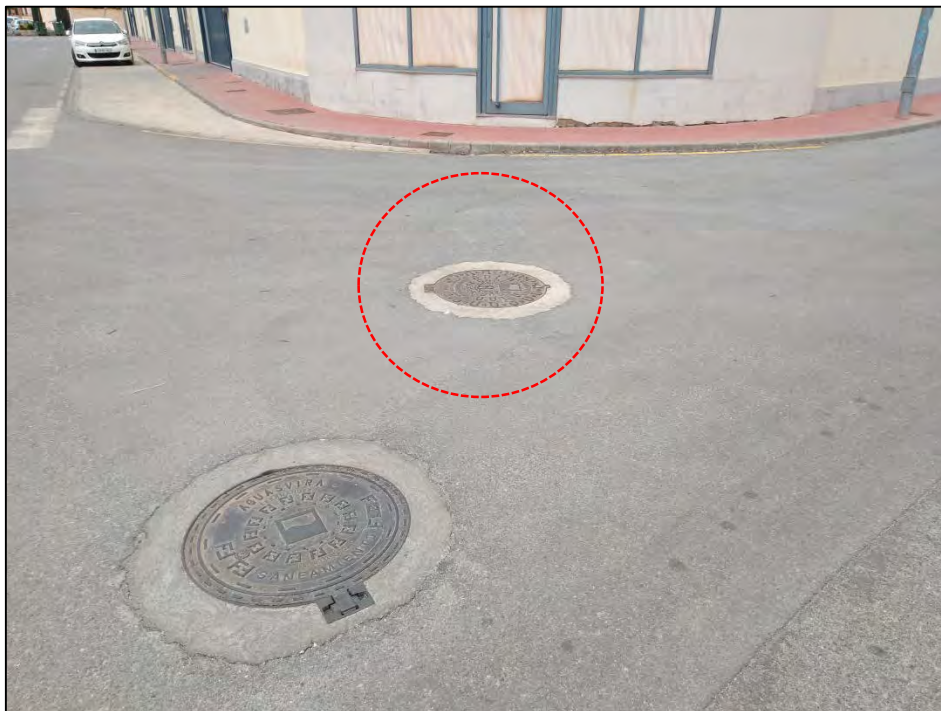
Figura 3.8. Pozo 133 intersección C/ Castilla y León-Plaza Navegran
