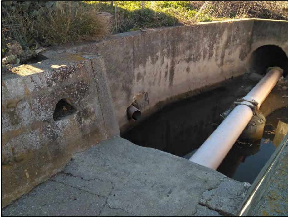
Figura 3.5. Salida de fecales del embovedado hacia barranco del Purcal PVC 315 mm
