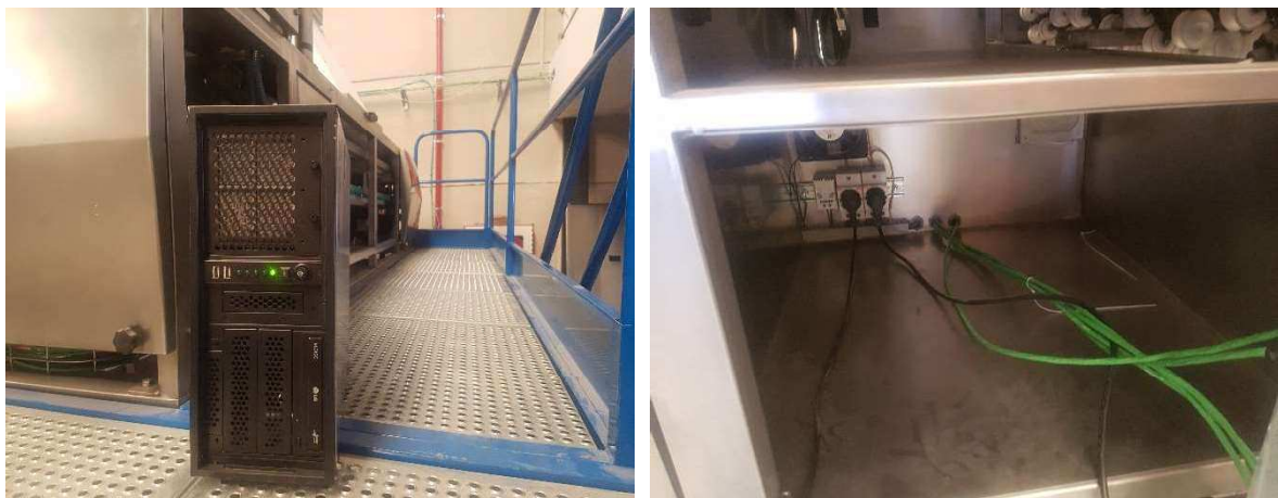
Figura 2.18. CPU y colocación
