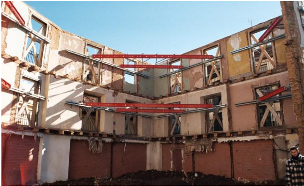
Imagen 9: Estabilización mixta de una vivienda en Valladolid
