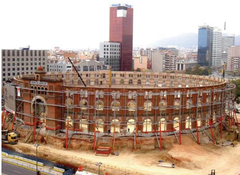
Imagen 8: Estabilización exterior del C.C. Arenas en Barcelona
