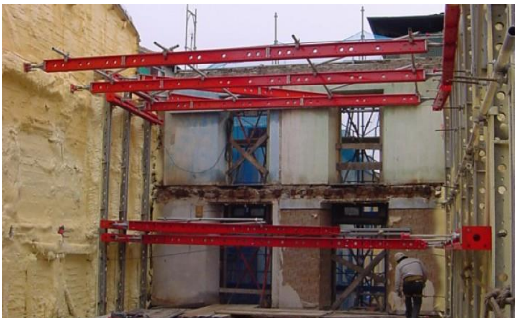
Imagen 7: Estabilización interior de una vivienda en Ponferrada
