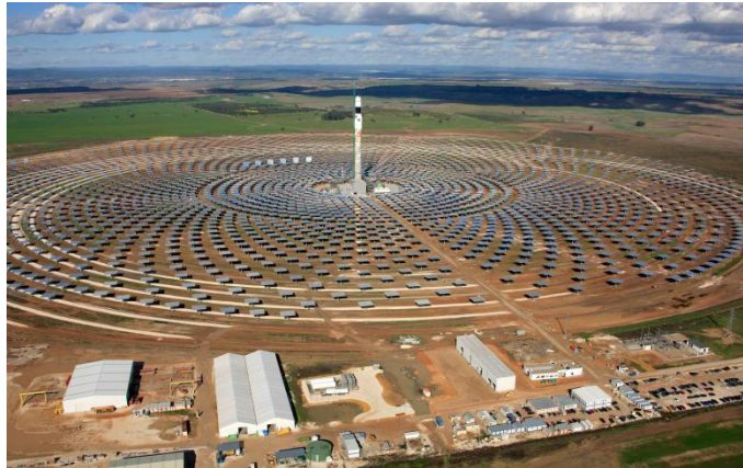
Figura 23. Central térmica solar de heliostatos
