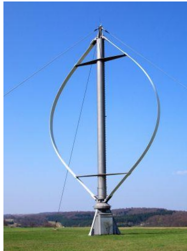
Figura 8. Aerogenerador de eje vertical
