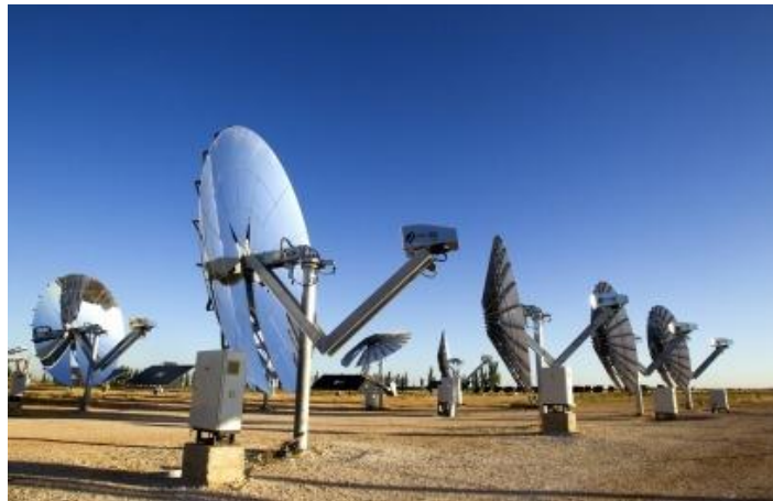
Figura 25. Central térmica solar con discos parabólicos Stirling
