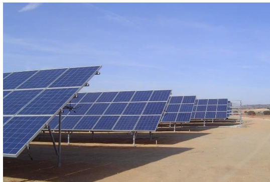
Figura 14. Estructura fija al suelo
