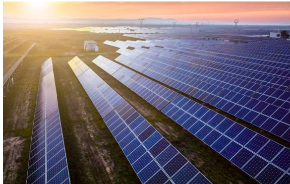
Figura 19. Planta solar de hileras continuas
