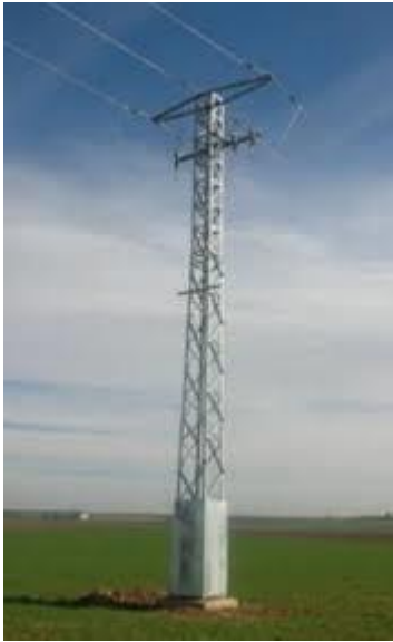
Apoyo de Celosía
