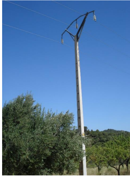
Apoyo de Hormigón
