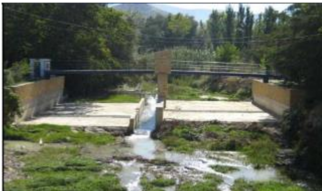
Ilustración 3: Estación n de aforo Quiebrajano en Puente Jontoya
