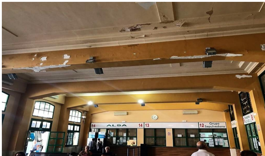
Imagen 89: Instalaciones de la Estación de Autobuses (III)
