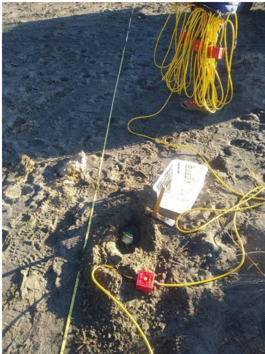
Figura 2. 13. Extensión del cable.
