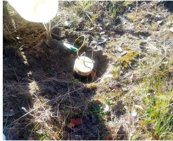
Figura 2. 12. Regado del electrodo.
