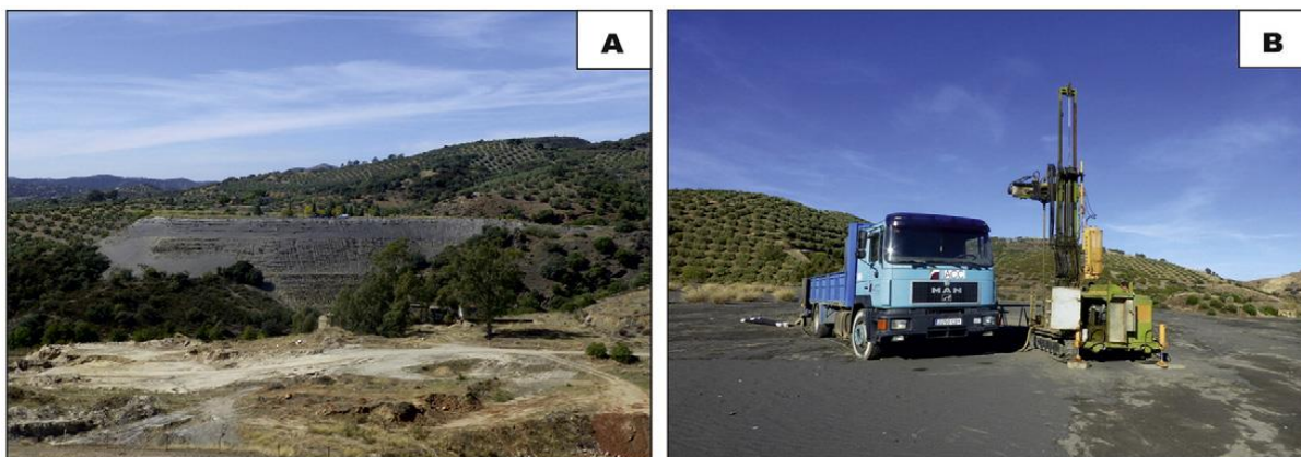
Figura 1. 9. A) Vista de la presa de lodos de La Aquisgrana. B) Operaciones de perforación (Martínez J. et al., 2016)
