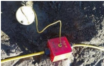
Figura 3. 5. Conexión del electrodo a la caja y con el cable.
