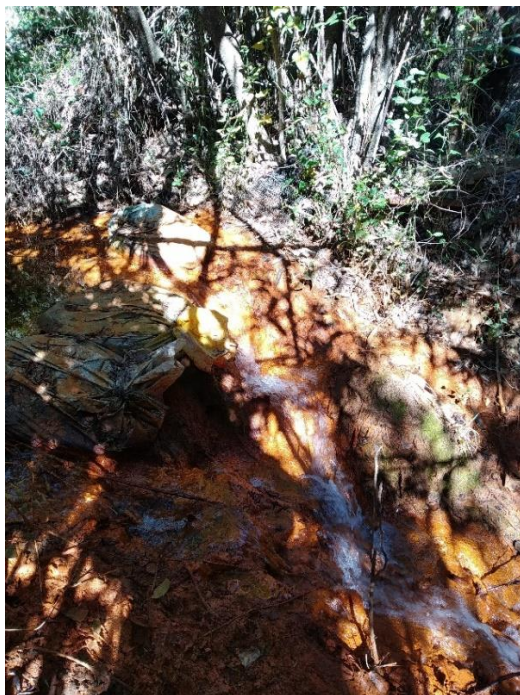
Figura 3. 16. Salida del desagüe de la presa
