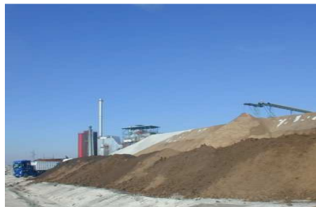
IMAGEN 26: Parque de combustible.
