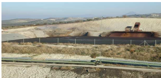
IMAGEN 21: Balsa de Recepción.
