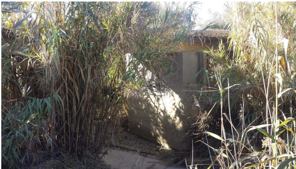
Ilustración 1. Puente en camino. Afección Ise1. P.K. 0+948
