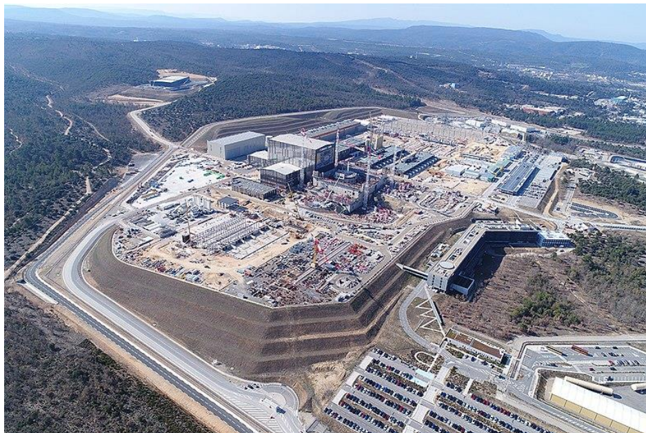
Construcción del proyecto ITER en Cadarache, Francia (ITER)
