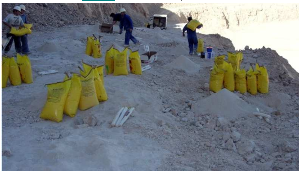
FIG 1.60 . Carga de la voladura.
