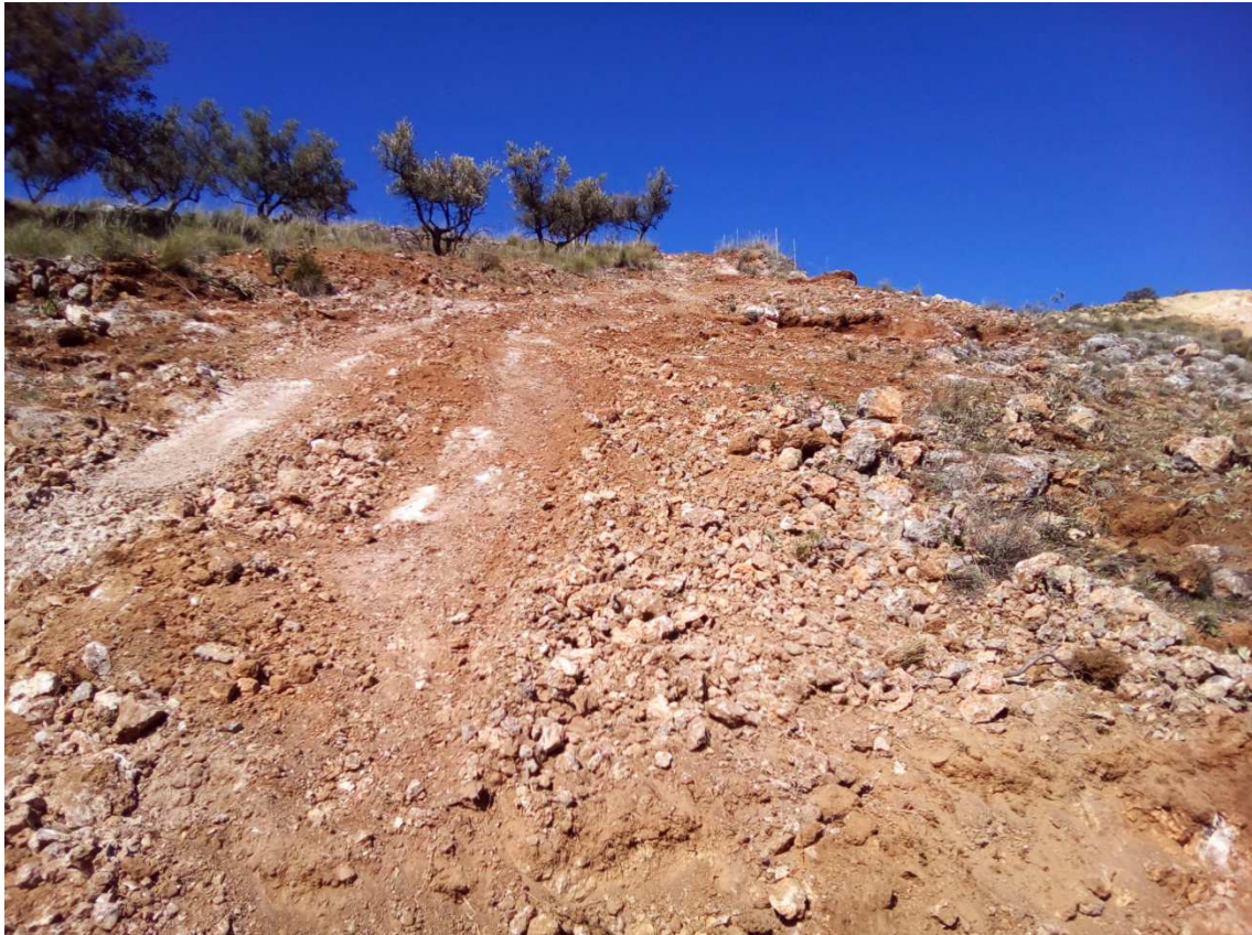
FIG 1.27. Destape y acondicionamiento del terreno.
