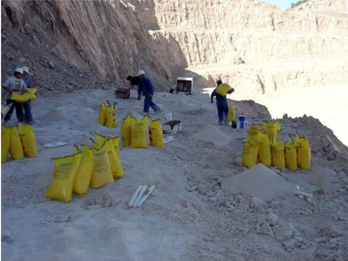
FIG 1.29 .. Carga de la voladura.
