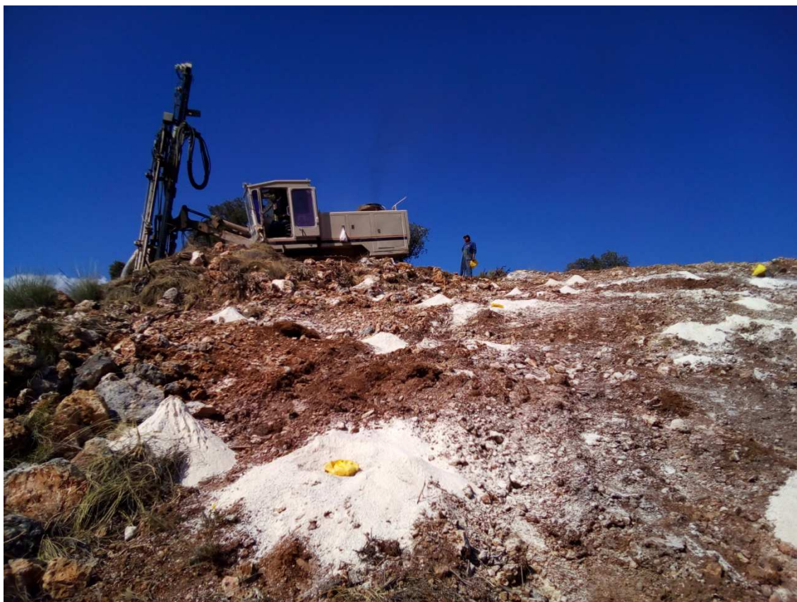
FIG1.58 Perforación de los barrenos.
