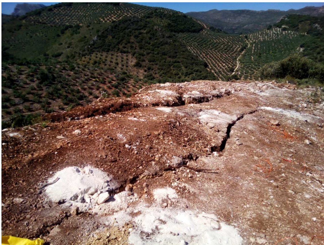
FIG 1.63. Fracturas generadas tras la pega.
