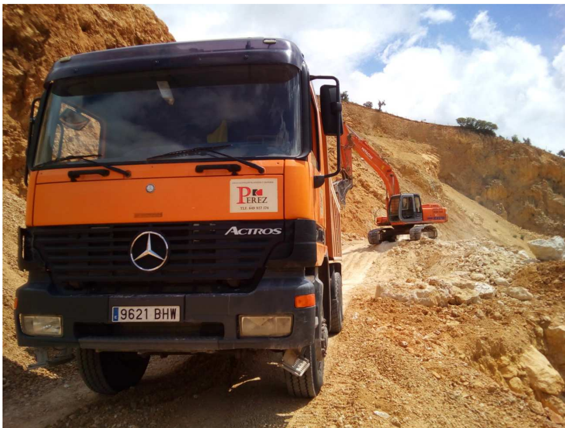
FIG 1.67. Transporte del material en camión .
