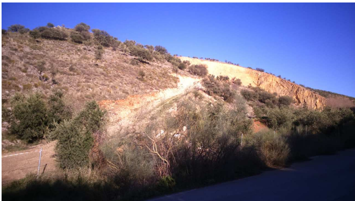
FIG 1.39. Carretera y creación de accesos la zona superior.
