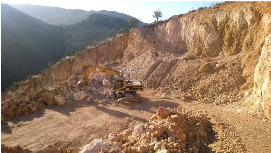
FIG 1.65. Saneamiento de las zonas inestables.
