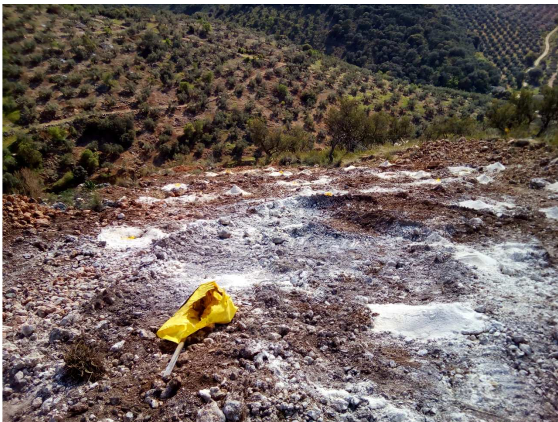
FIG 1.59 Malla de barrenos perforados.
