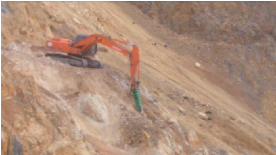
FIG 1.30. Excavadora saneando frente volado.
