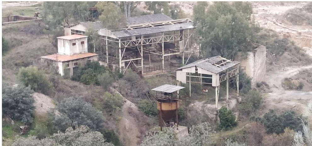
Imagen 1.14: Vista del antiguo lavadero de La Aquisgrana
