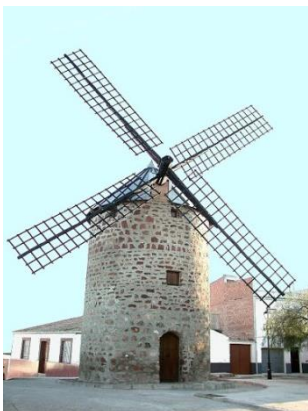
Imagen 36: Molino de Viento (Baños de la Encina)
