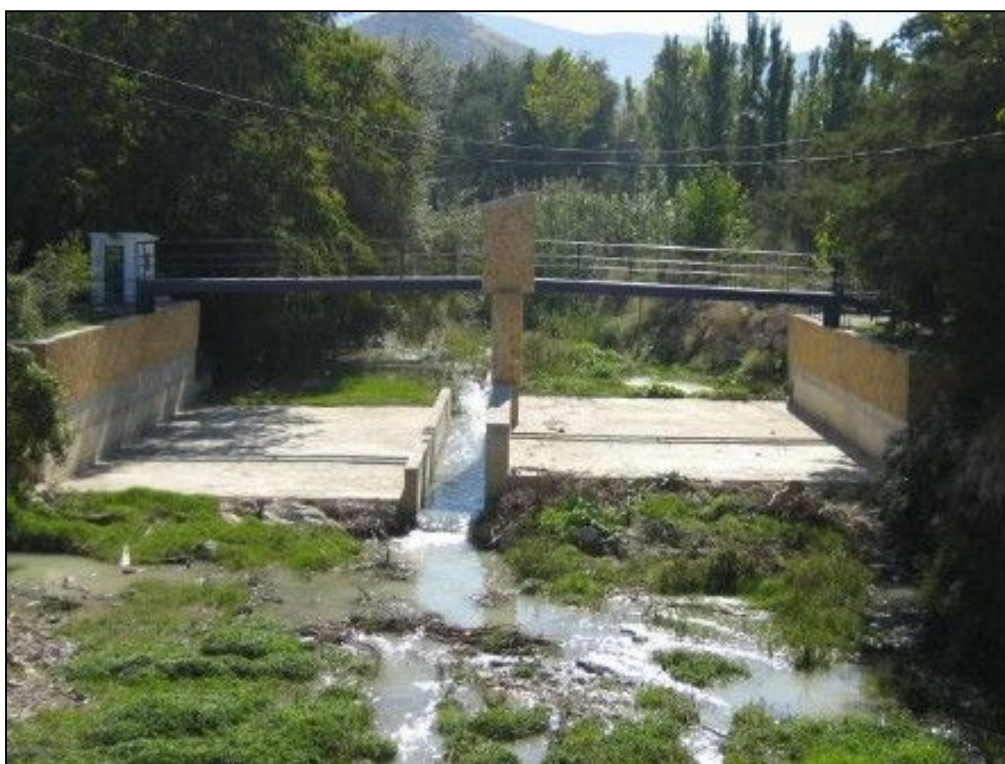
Figura 13. Estación de aforos 5084 (Puente Jontoya) sobre el río Jaén. Fuente 8 .
