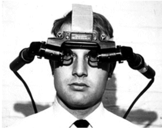
Ilustración 33: Primeros prototipos de casco ( Head Mounted Display ). (Extraído de: http://goo.gl/9nY4gr )
