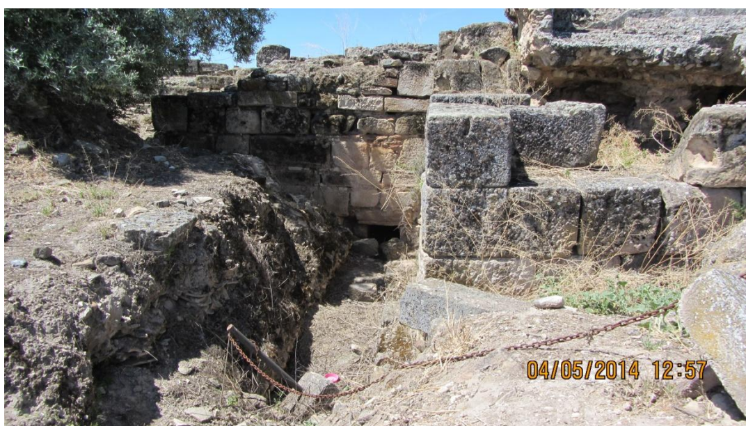
Figura 59. Desagüe de las termas, Villa del Olivar (Cástulo. Linares).
