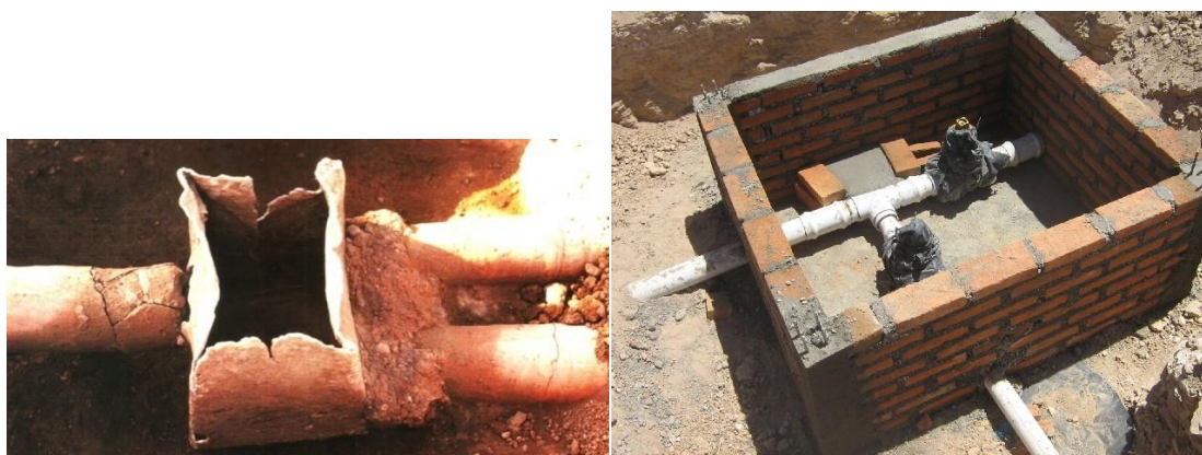
Figura 55. Arquetas de registro, a: arqueta de plomo romana (procedente de la población de Valderrepisa (Fuencaliente, Ciudad Real)), b: arqueta de obra actual (procedencia desconocida).
