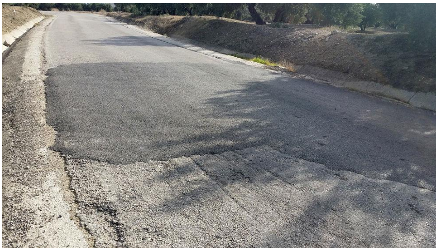
Figura nº 27 – Parcheado de la carretera
