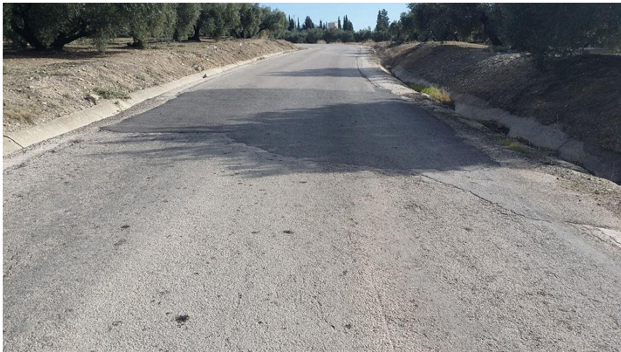
Figura nº 26 – Parcheado de la carretera
