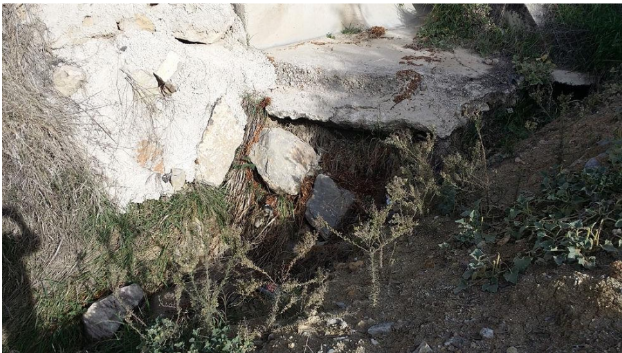
Figura nº 35 – Mal estado de la obra de drenaje transversal
