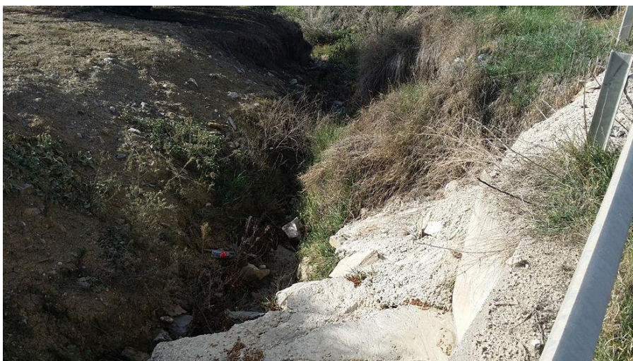
Figura nº 33 – Pie de obra de drenaje transversal
