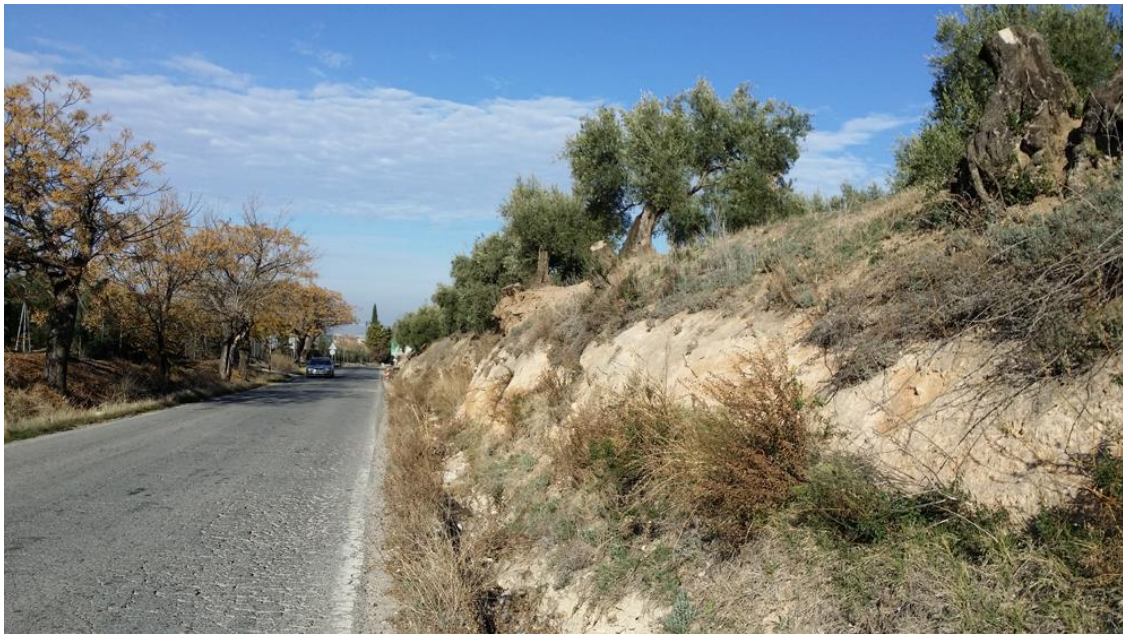
Vistas de la carretera en el P.K. 0+000
