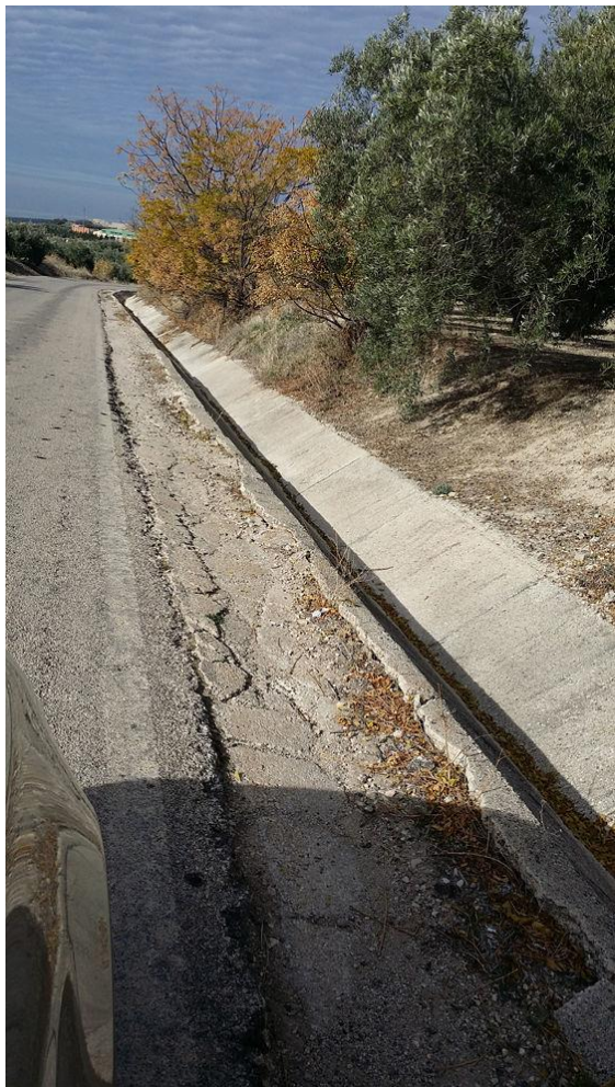
Figura nº 20 y 21 – Arcenes en mal estado de conservación
