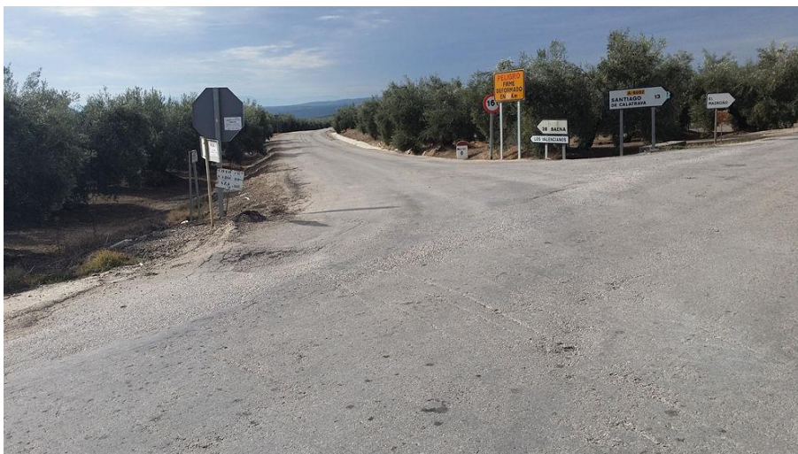
Figura nº 45 – Desvío carretera JV-2131 dirección Baena
