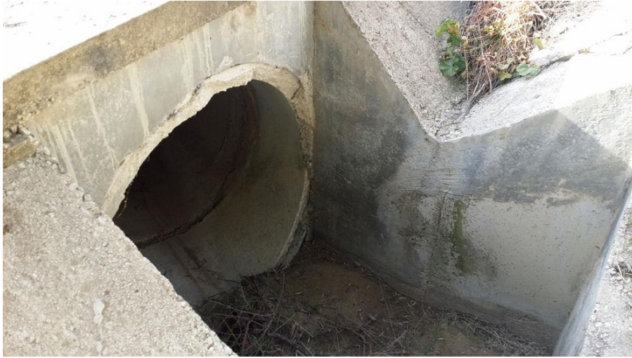
Figura nº 30 – Entrada a sumidero
