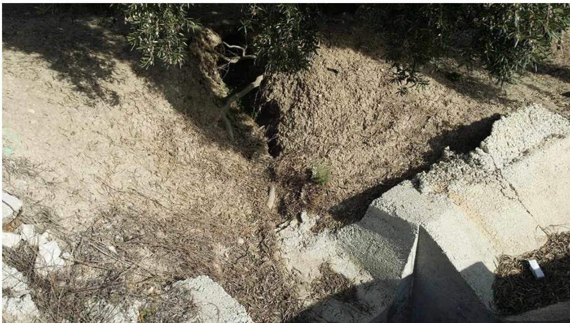
Figura nº 29 – Entrada a sumidero
