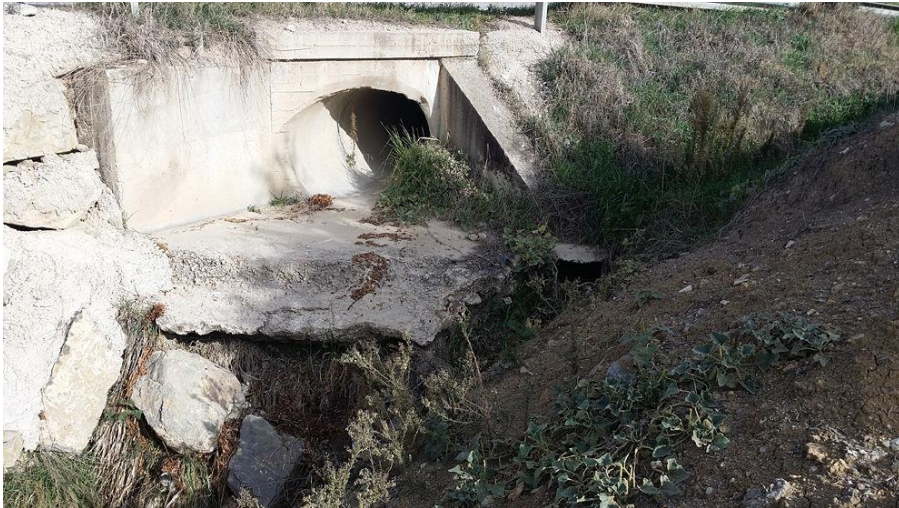
Figura nº 34 – Obra de drenaje transversal
