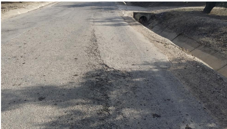
Figura nº 24 – Hundimiento
