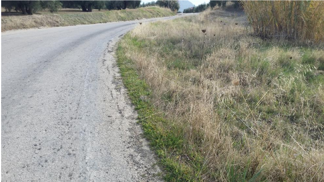
Figura nº 19 – Lateral de la carretera sin arcenes
