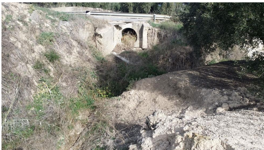
Figura nº 35 – Mal estado de la obra de drenaje transversal
