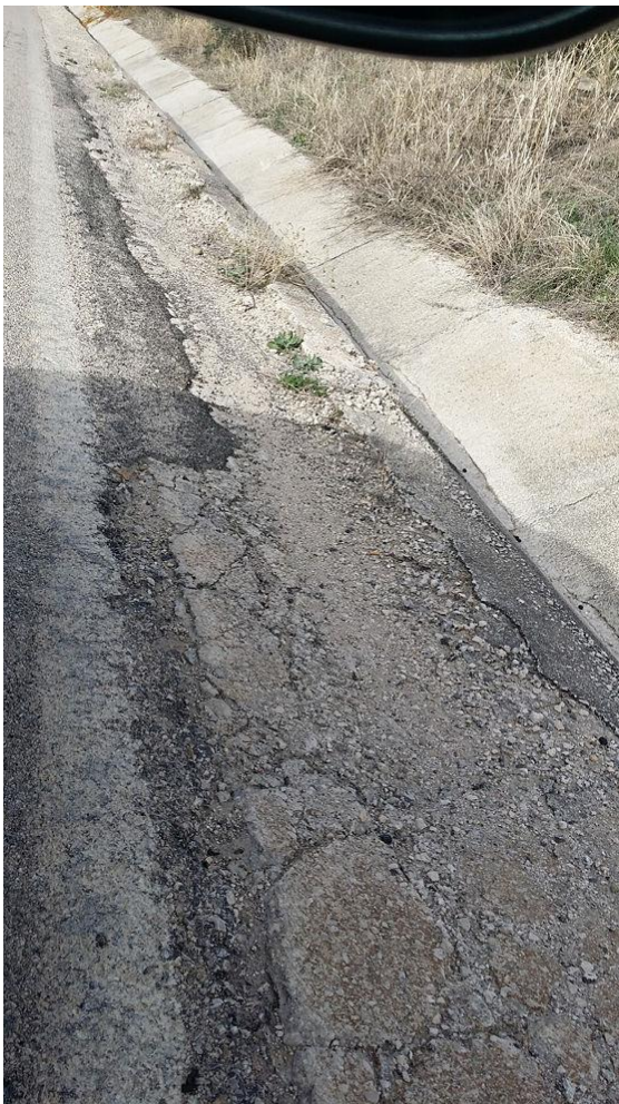
Figura nº 20 y 21 – Arcenes en mal estado de conservación
