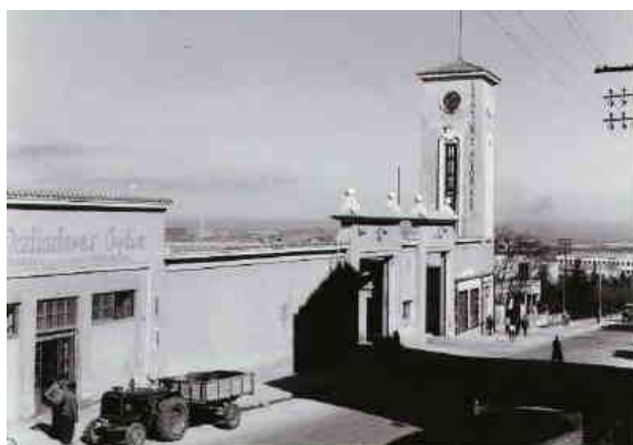
Imagen 26: Fachada de la estación de autobuses durante su año de inauguración
