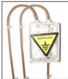
Figura 3. Caja de seccionamiento de protección
