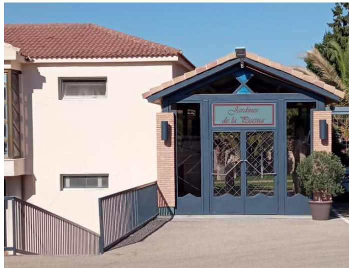
Imagen 4. Tipología estructural de la puesta que da a la piscina y de parte de uno de los salones. (Facilitado por la propiedad).
