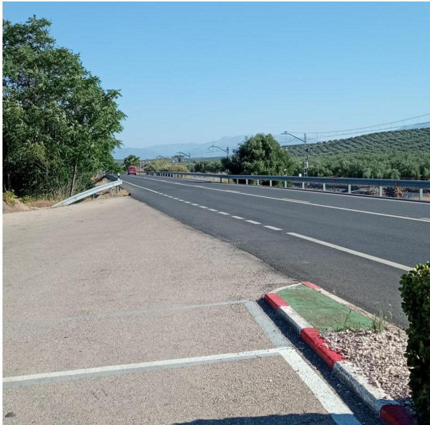
Imagen 9. Carretera N323 Bailén-Motril. Acceso al complejo.
