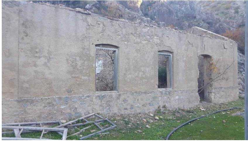
Ilustración 4.11. Almacén y taller de reparación
