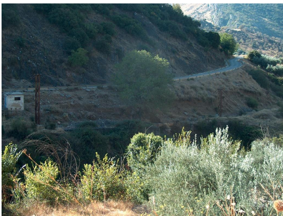
Ilustración 4.26. Apoyos de sujeción del tramo de tubería
