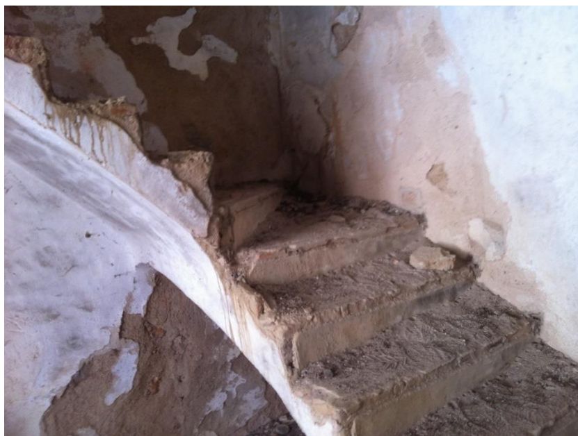
Ilustración 4.8. Escaleras de subida a la oficina
