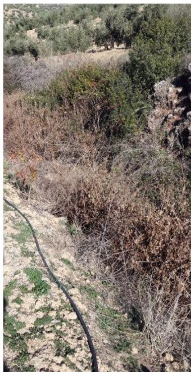
Ilustración 4.25. Tramo de canal abierto
