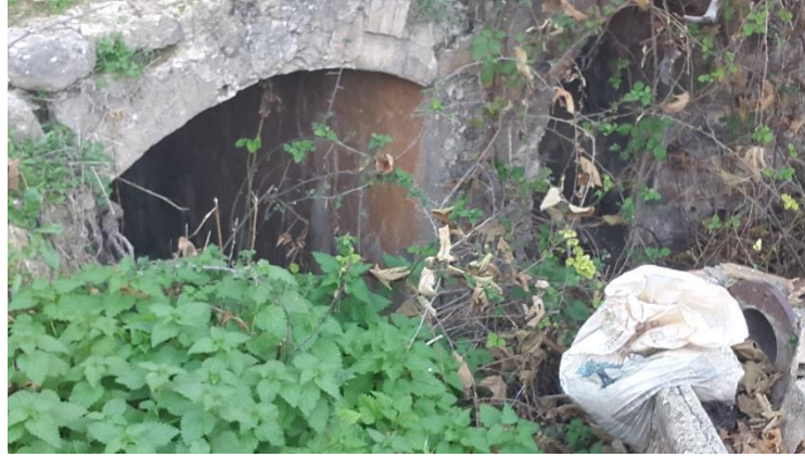
Ilustración 4.13. Salida del agua de la central para su descarga en el río
