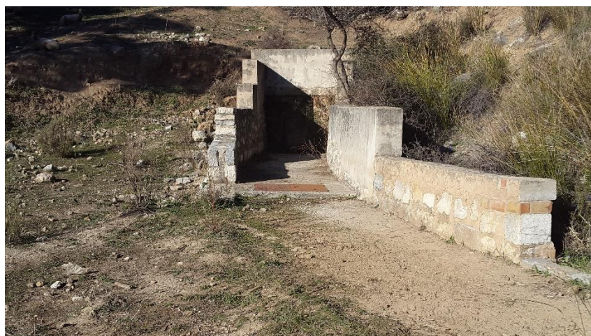
Ilustración 4.24. Comienzo subterráneo del canal
