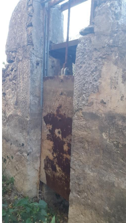
Ilustración 4.37. Compuerta de desagüe del primer desarenador
