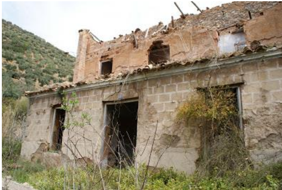
Ilustración 4.14. Vivienda de trabajadores
