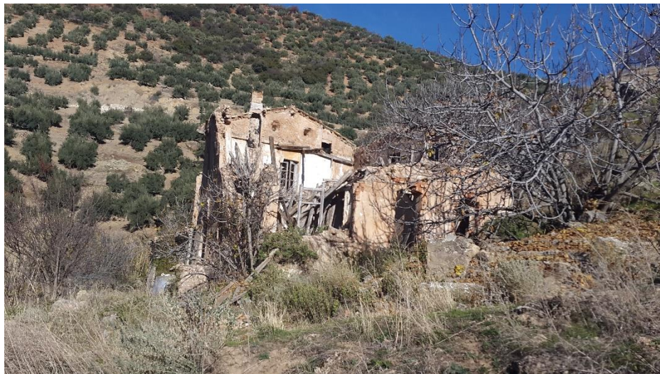
Ilustración 4.15. Vivienda de trabajadores
