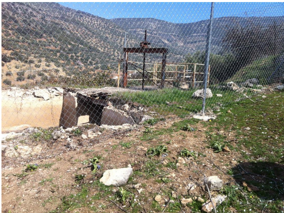
Ilustración 4.31. Exterior de la cámara de carga
