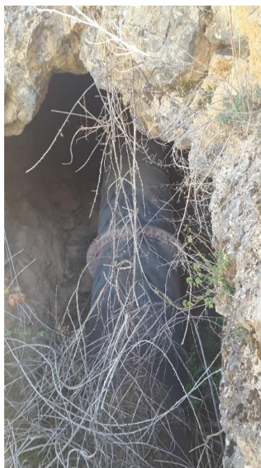
Ilustración 4.47. Tubería forzada en el tramo enterrada
