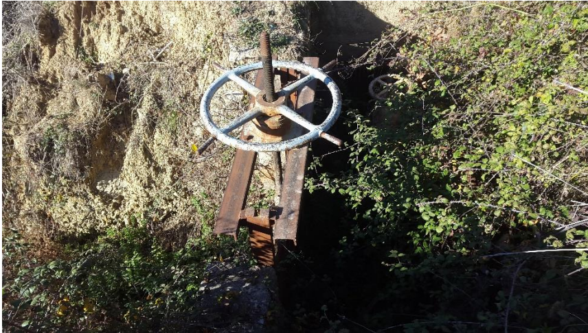
Ilustración 4.40. Compuerta de desagüe del primer desarenador
