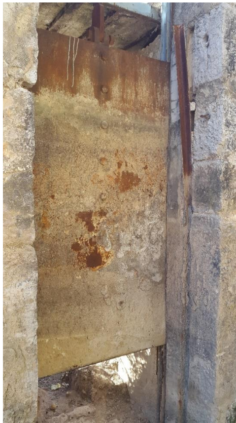
Ilustración 4.39. Compuerta de desagüe del segundo desarenador
