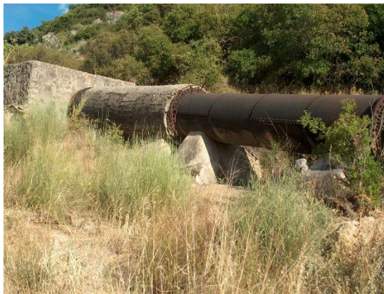
Ilustración 4.45. Macizo de anclaje
