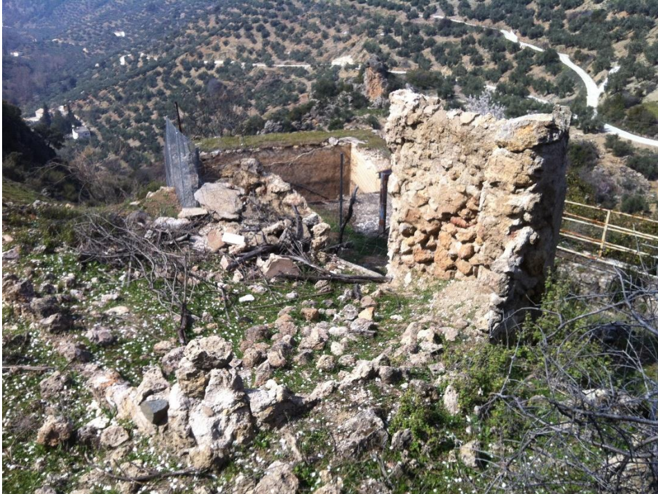
Ilustración 4.33. Edificio auxiliar totalmente destruido
